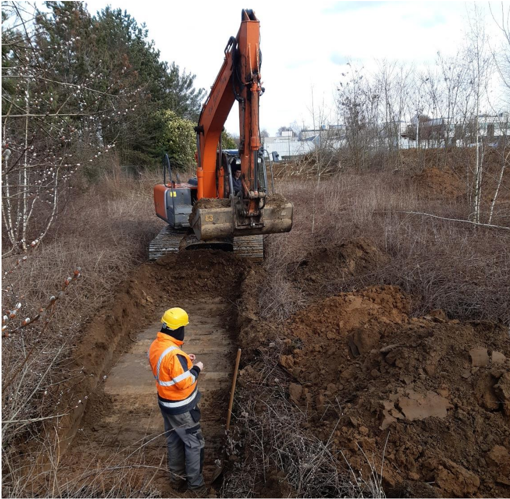
Figuur 10: Foto's methodiek: aanleg van sleuf
