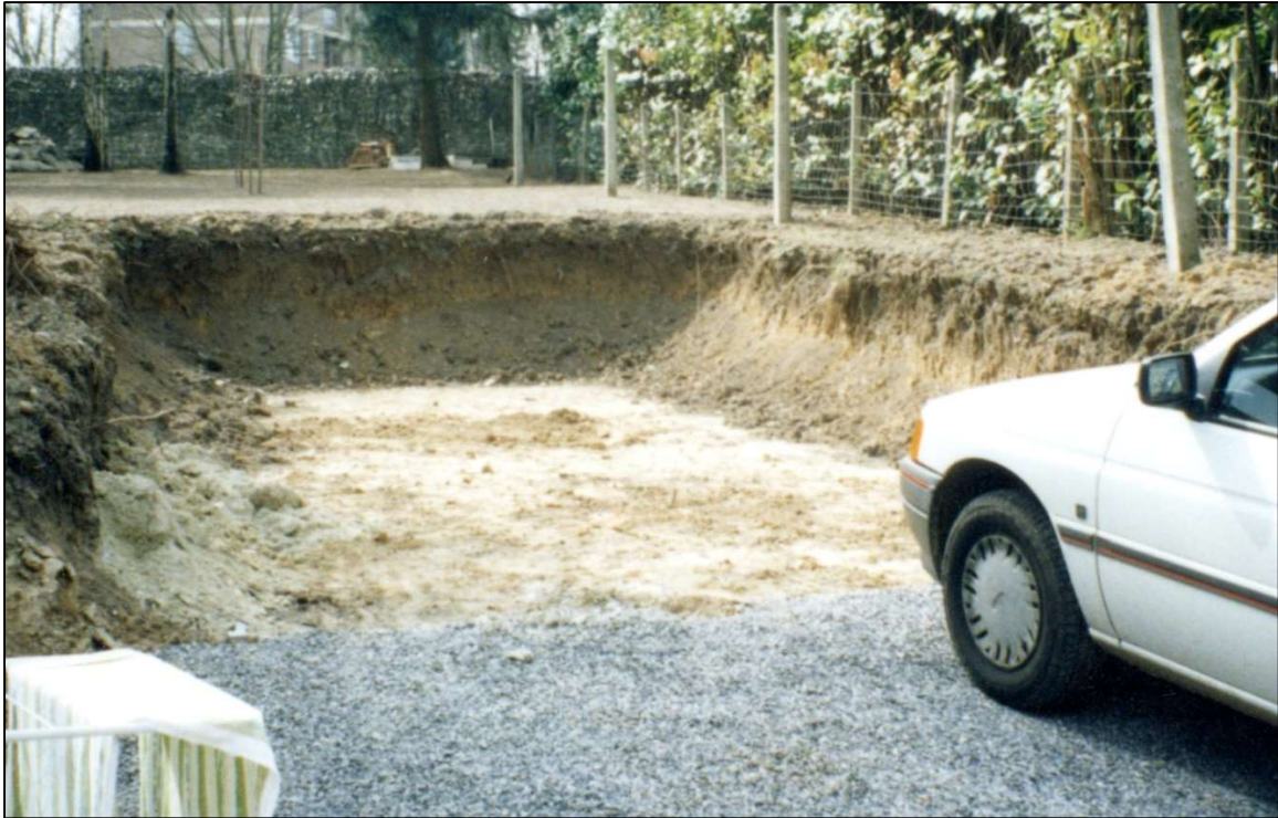
Afb. 37: Foto van de aanlegput voor een garage in de tuin van Rode Kruislaan 46.
