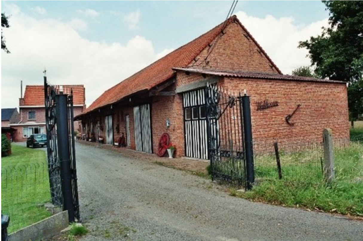
Fig. 4. Foto van de schuur die haaks op de Langenaardestraat gelegen is. Foto genomen op 1/10/2006 door Helena Duchêne ( https://id.erfgoed.net/afbeeldingen/112567 ).
