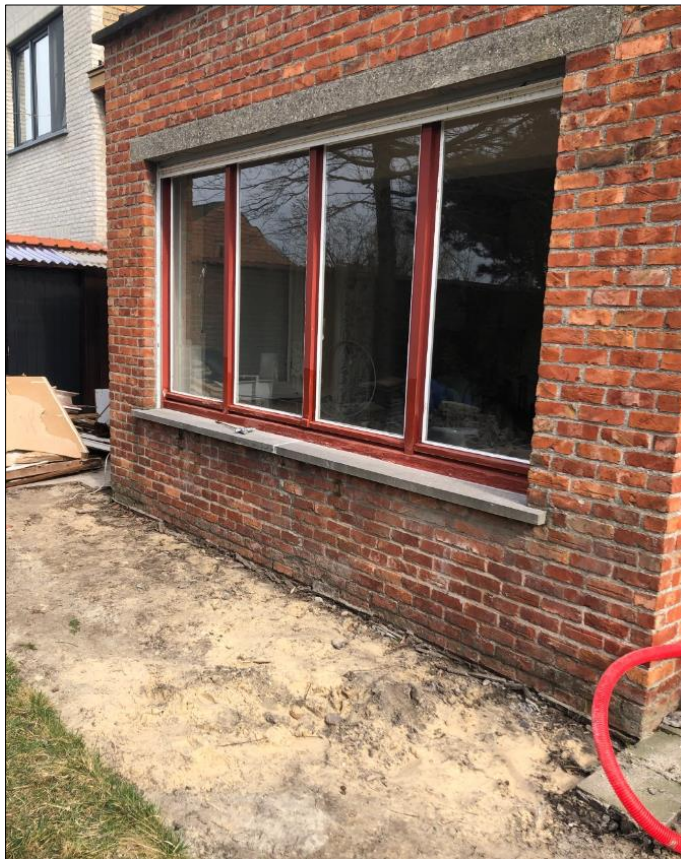
Figuur 5: Bestaande uitbouw binnen de projectgrenzen met aansluitend de terraszone waar de betondallen recent zijn verwijderd (bron: opdrachtgever).
