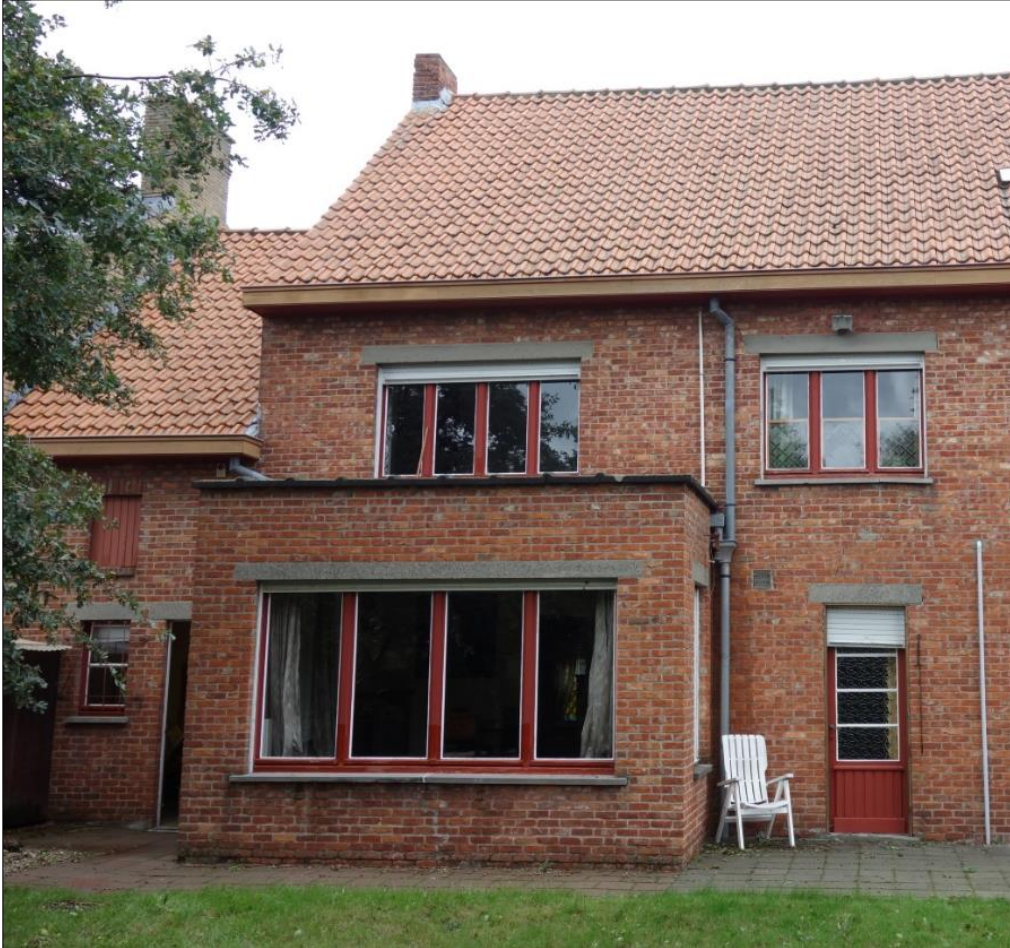
Figuur 4: Bestaande achtergevel met uitbouw. (bron: opdrachtgever).
