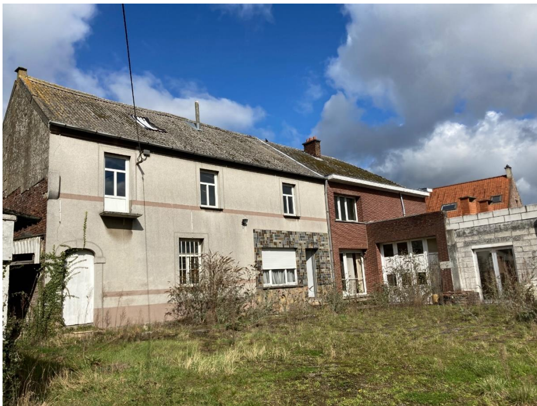
Figuur 8: Foto van de bestaande toestand, met zicht op de achterzijde van de woningen
