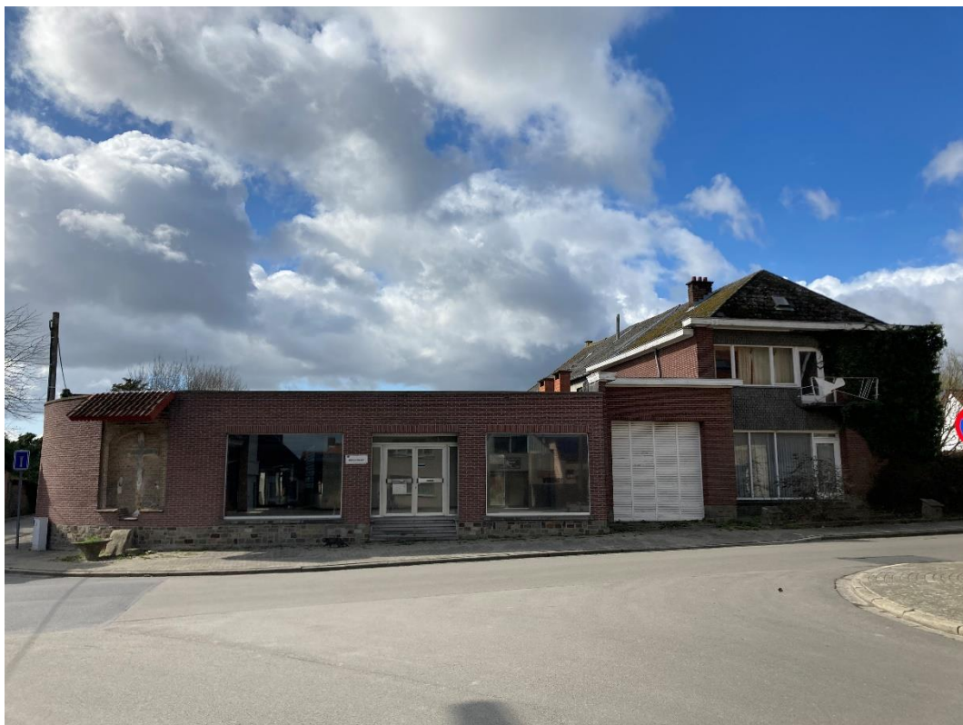
Figuur 5: Foto van de bestaande toestand, genomen vanaf de straatzijde, met zicht op de showroom (links) en de woningen (rechts)
