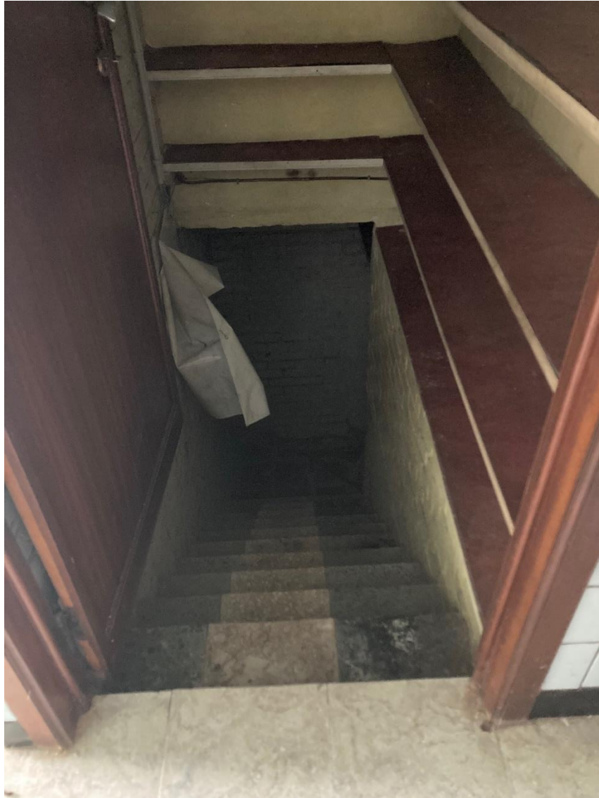
Figuur 13: Foto van de trap naar de bestaande kelder onder het woonhuis
