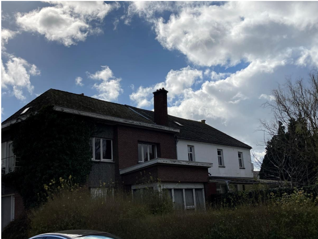
Figuur 6: Foto van de bestaande toestand, genomen vanaf de straatzijde, met zicht op het bruine en het witte woonhuis
