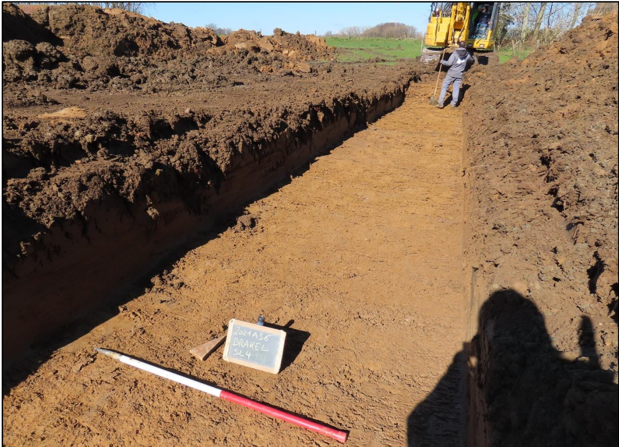
Figuur 12 Sfeerbeeld tijdens de aanleg van de sleuven.
