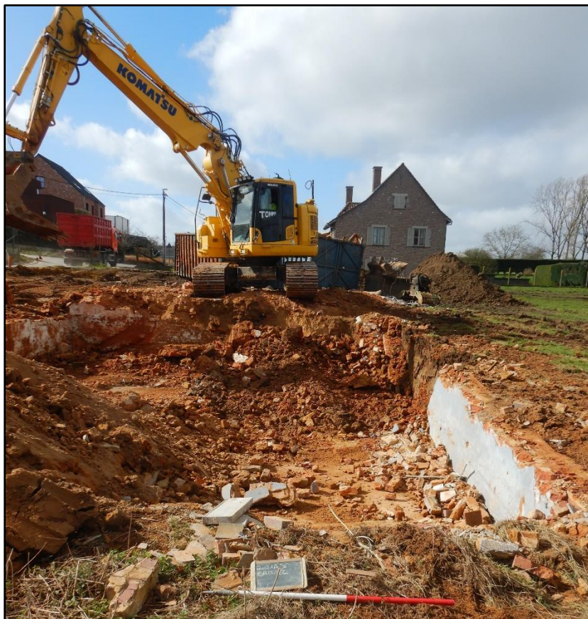
Figuur 6 Begeleiden van de sloop en uitbraak van de grote kelder in de hoeve.
