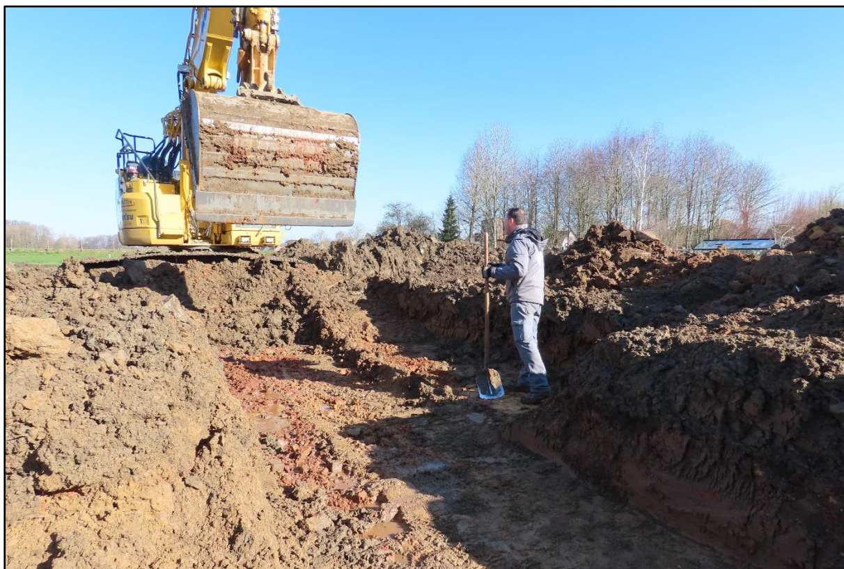
Figuur 11 Sfeerbeeld bij de aanleg van de sleuven.
