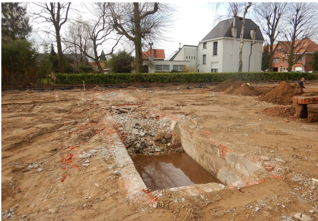
Figuur 29: Restant van een kelder ter hoogte van proefsleuf 3.
