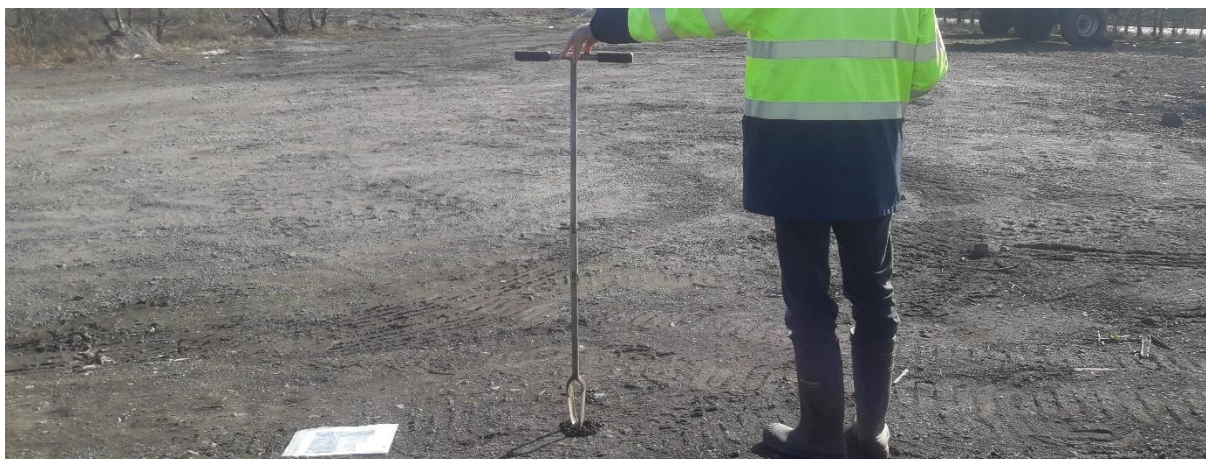
Figuur 6 : Zicht op het plangebied WT11 ter hoogte van boring 9, gezien vanuit het westen.
