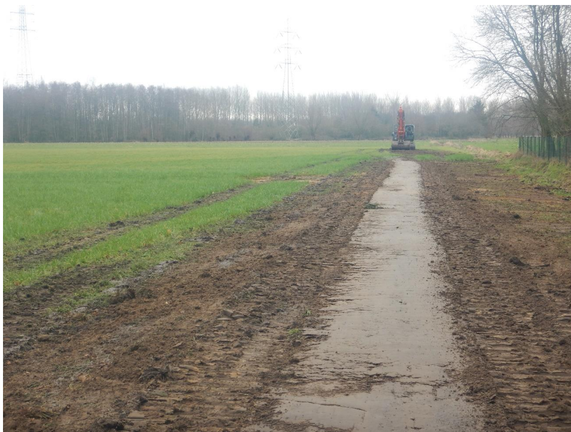
Figuur 6: Zicht op de werkzone in het zuidoosten vanuit het noordoosten na dichting van de sleuf.
