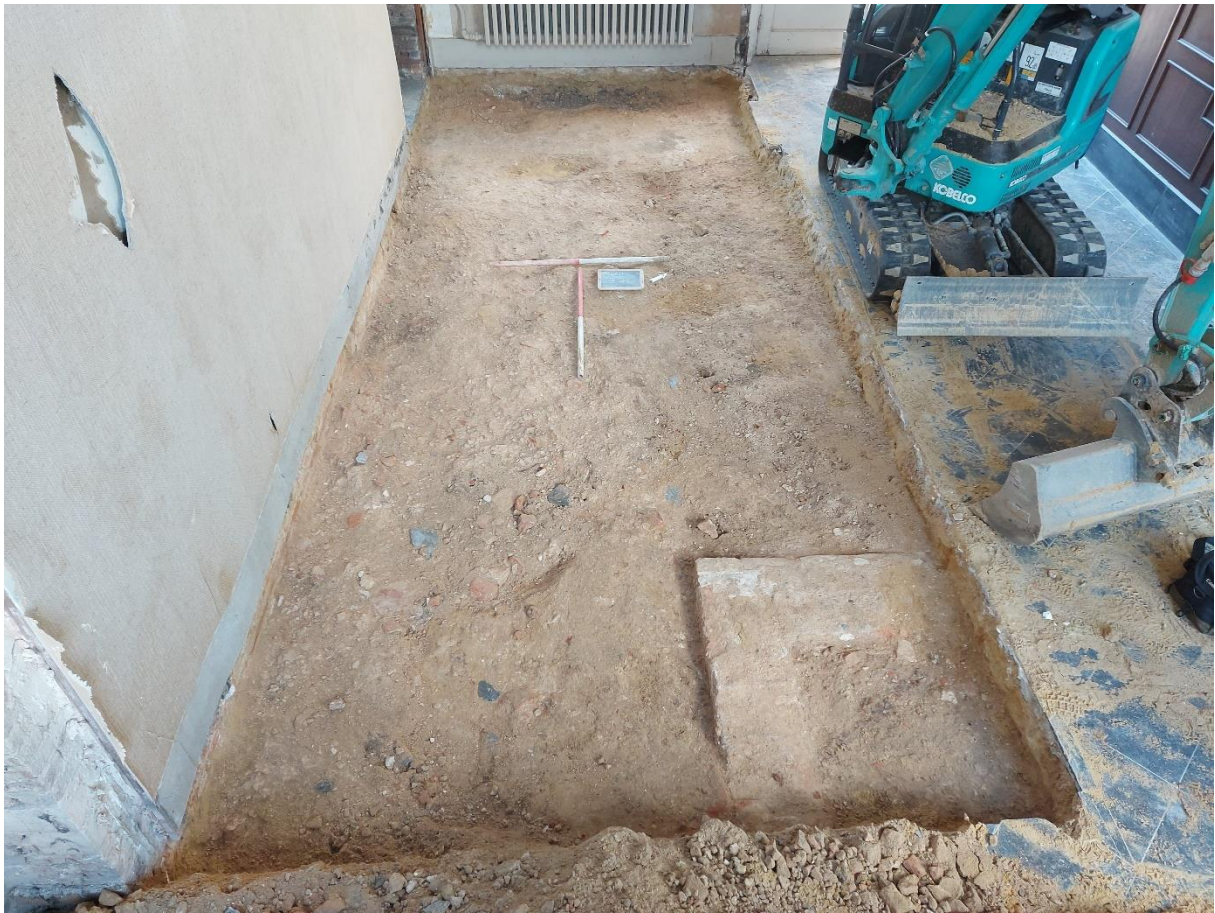
Figuur 7: Zicht op werkput 3 vlak 1 aangelegd met behulp van een minigraver. De kraan werd hierbij slechts ingezet voor het verwijderen van de aanwezige puinpakketten.
