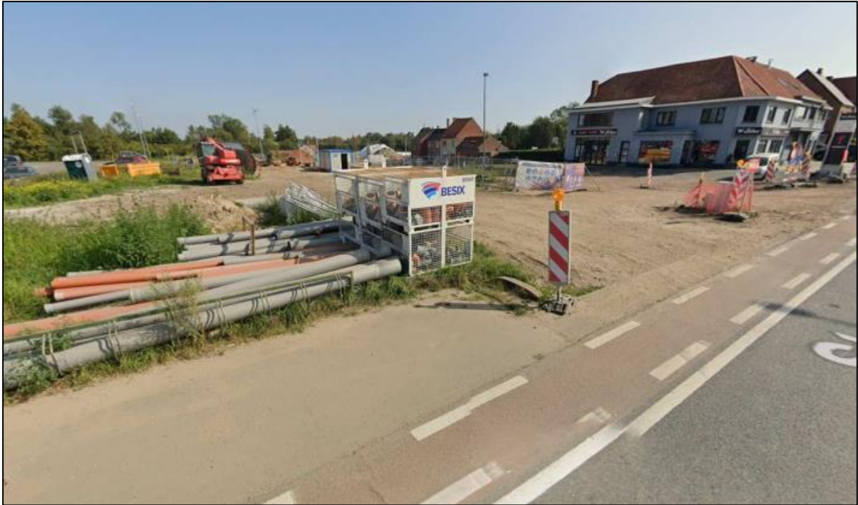
Figuur 2: Zicht op de werfzone voor de aanleg van de nieuwe brug aan de het kruispunt Steenweg-Waardestraat, gezien vanuit westen. 5
