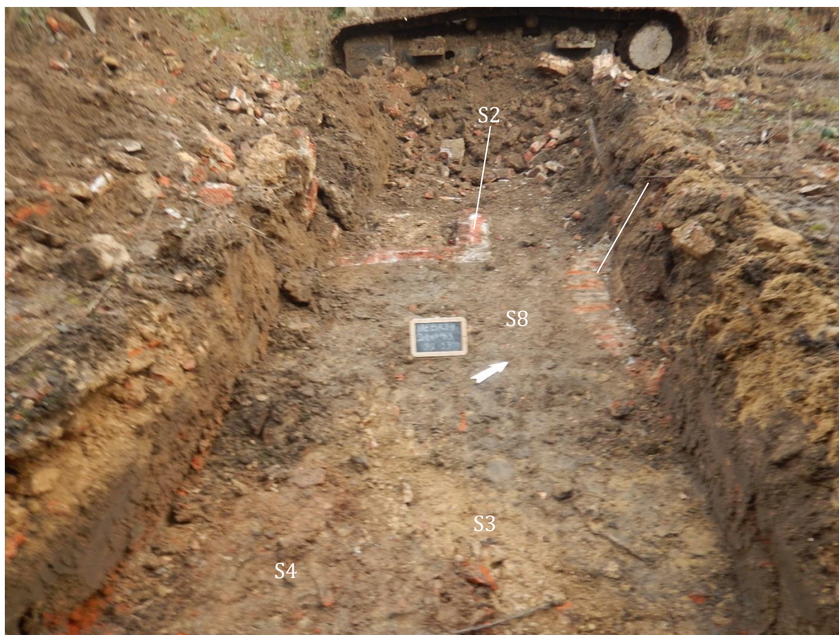
Figuur 40: Zicht op WP1 vanuit het zuiden.
