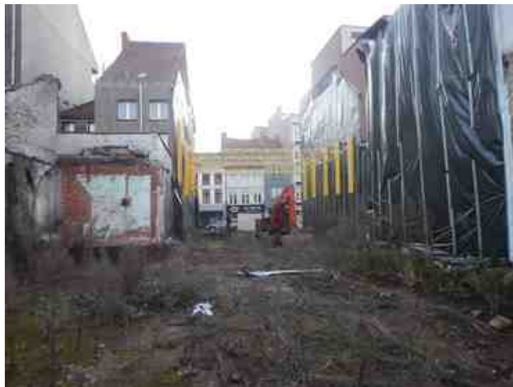
MEBR21 - 20210216 - 9.JPG - Spoornummer(s): / - Inventarisnummer(s): / - Structuur: Algemeen 1 - Zone/Werkput/Kijkvenster/Vlak: /
