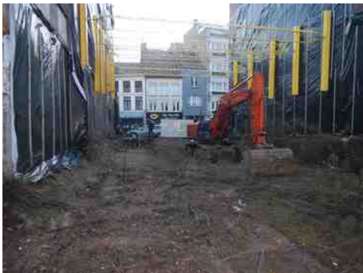
MEBR21 - 20210216 - 8.JPG - Spoornummer(s): / - Inventarisnummer(s): / - Structuur: Algemeen 1 - Zone/Werkput/Kijkvenster/Vlak: /
