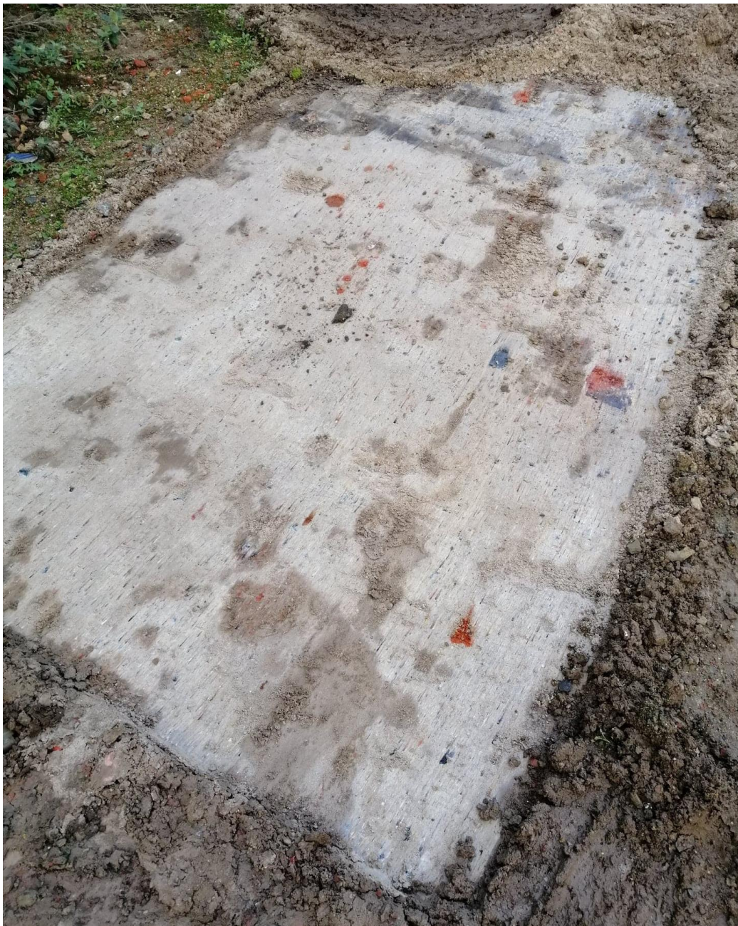
Figuur 2: Zicht op de harde verstoring direct onder het maaiveld, ter hoogte van de initieel ingeplande locatie voor WP 5, ten zuiden van WP 4.
