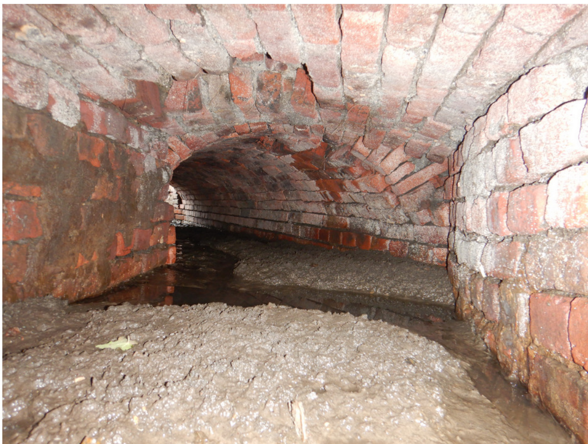
DEI-TOL_2021C280-C281_Caniveaux in zuidelijke richting
