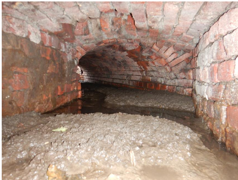
Figuur 9. Zicht op de inspectieput (met archeoloog) en de binnenzijde van de canivaux .
