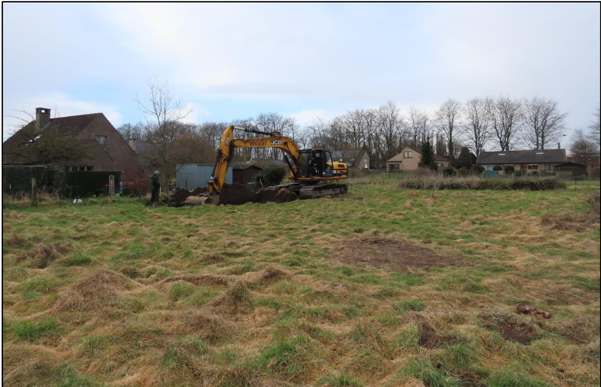
Figuur 8 Sfeerbeeld tijdens de aanleg van de sleuven.
