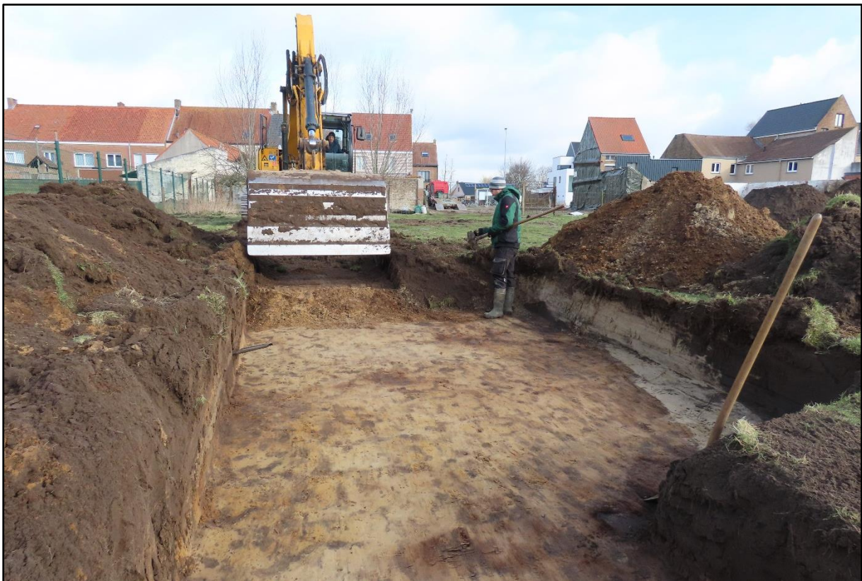
Figuur 9 Sfeerbeeld bij de aanleg van de sleuven en kijkvenster.
