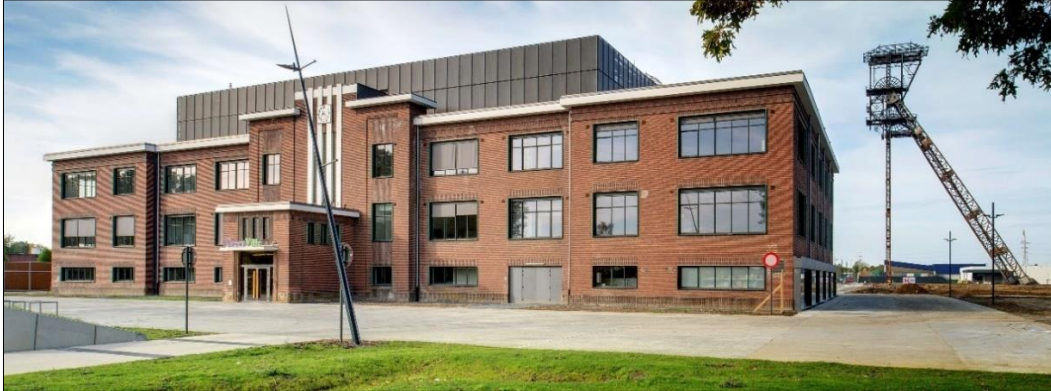
Figuur 11: Voorzijde van het hoofdgebouw met op de achtergrond de noordelijke schachtbok. (©Greenville)
