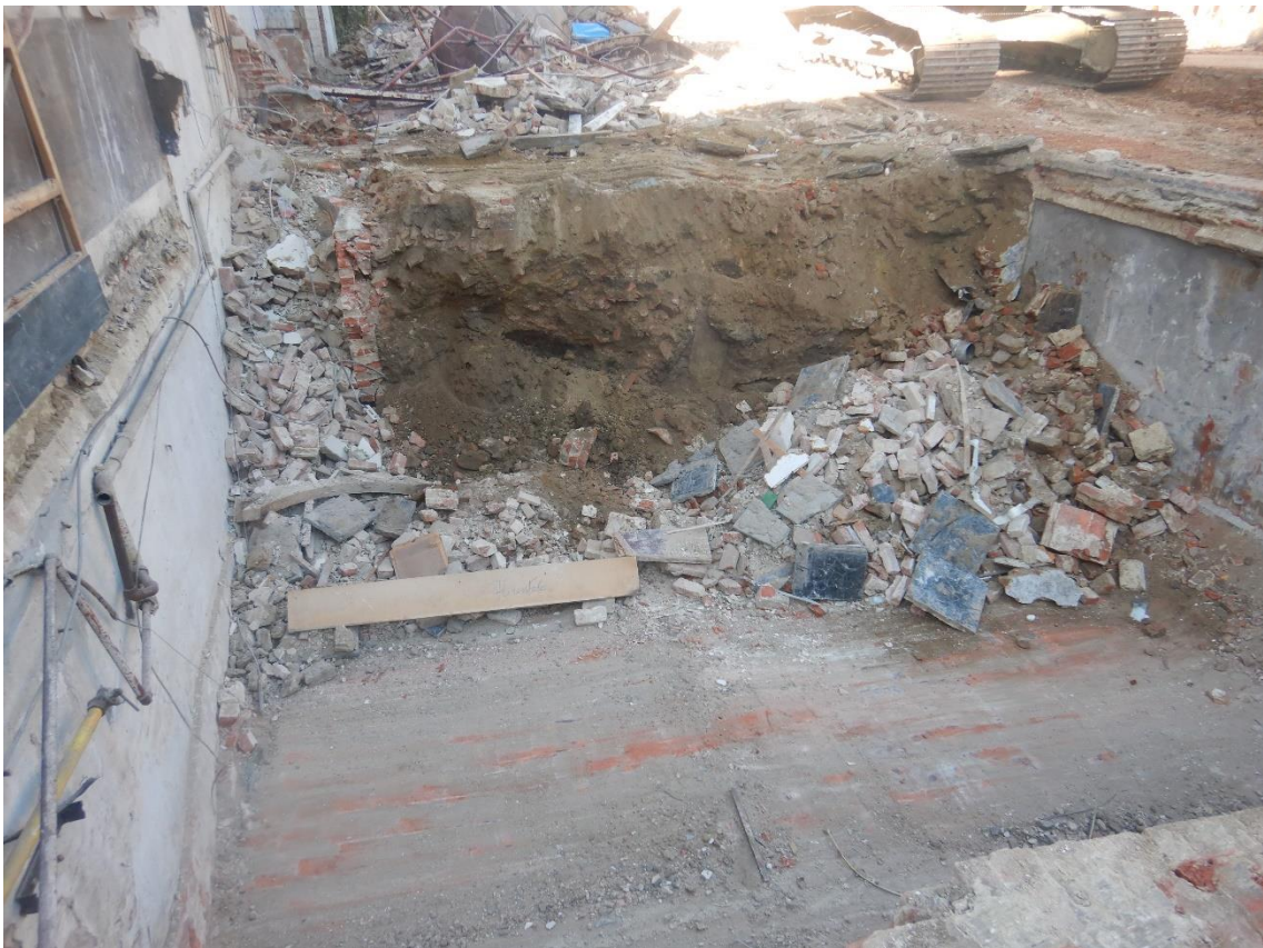
Figuur 12: Zicht op een kelder aan de straatzijde
