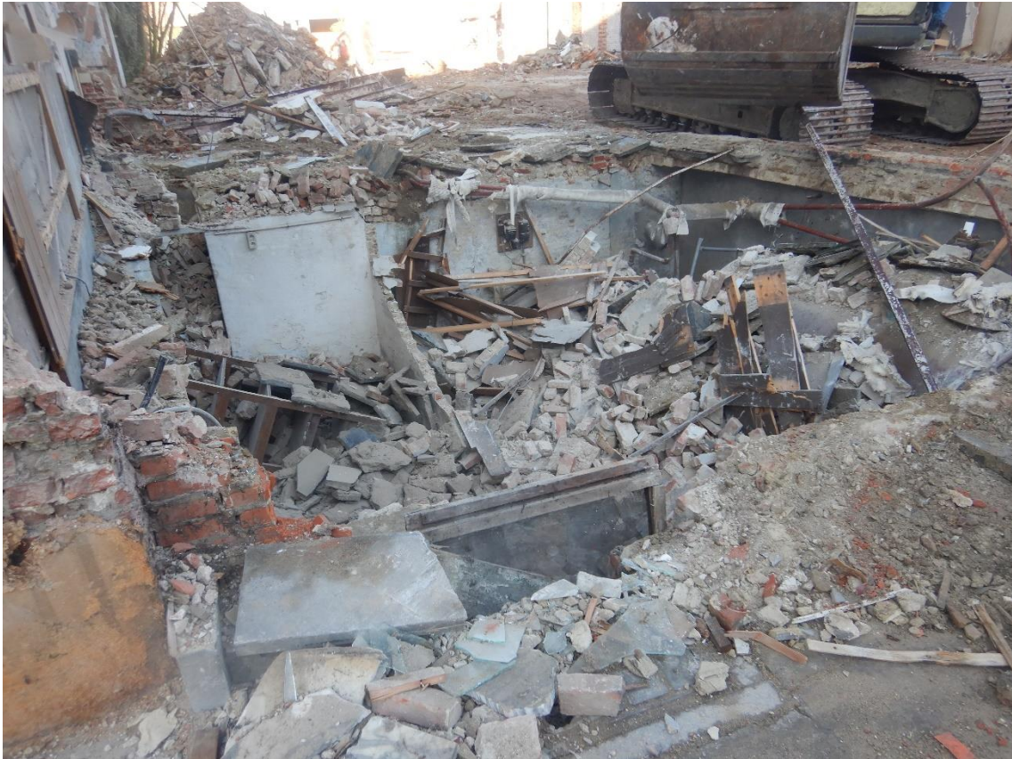
Figuur 11: Zicht op een kelder aan de straatzijde
