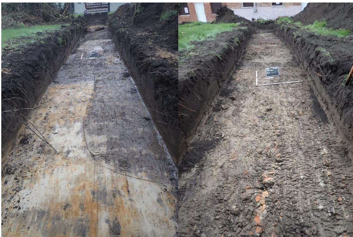
Figuur 19: Overzichtsfoto Werkput 3 en 4 (© J. Verrijckt Bvba)
