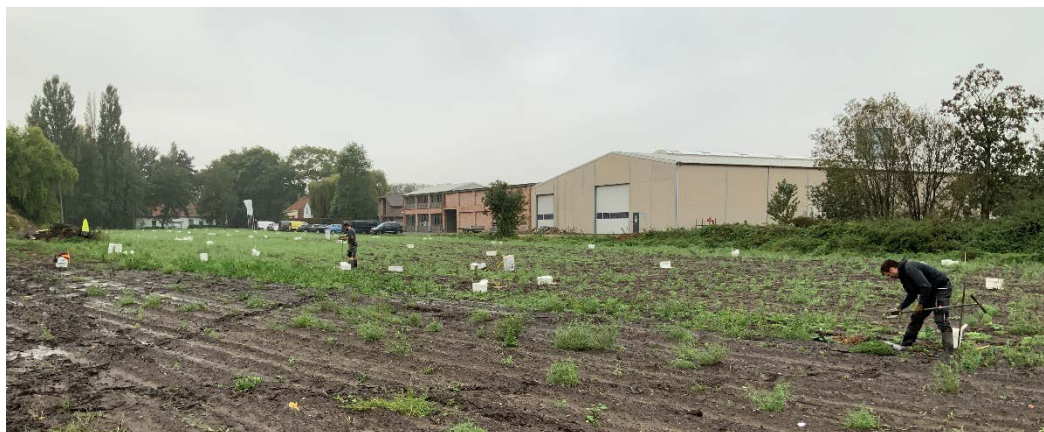
Figuur 24: Overzicht tijdens de werkzaamheden. De witte emmers stemmen overeen met de boorlocaties (GATE).
