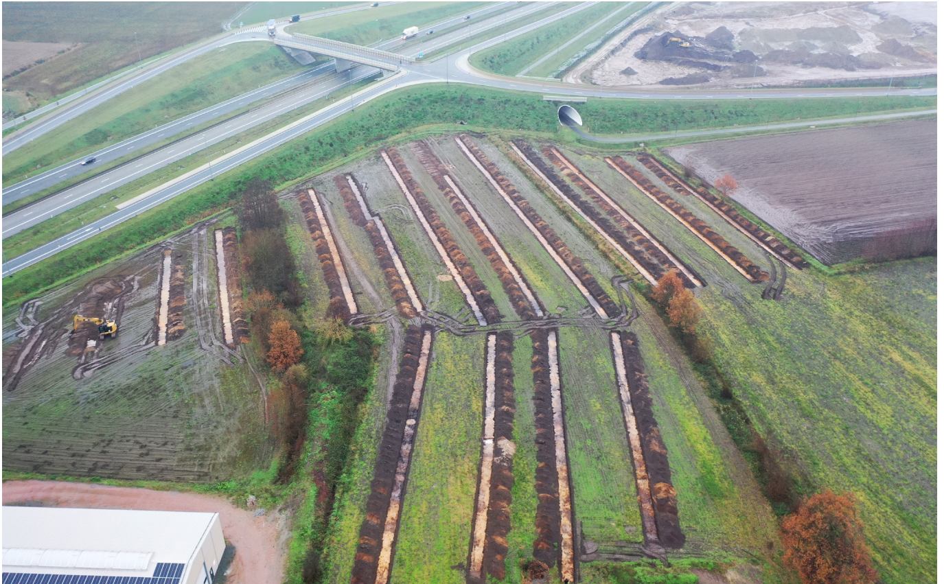
Figuur 10: Zicht vanuit het zuiden op een deel van de uitgevoerde sleuven
