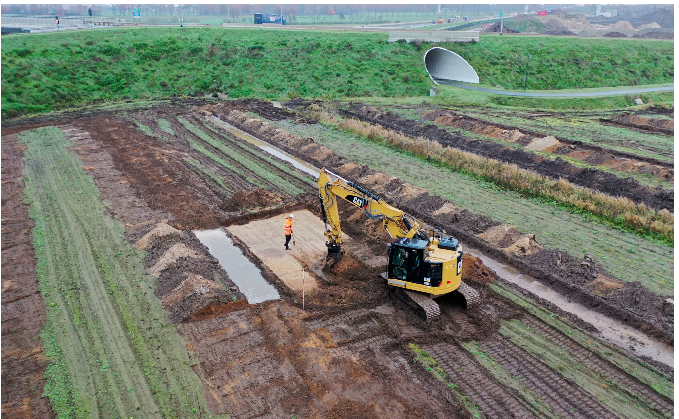
Figuur 11: Zicht op de aanleg van kijkvenster 1008
