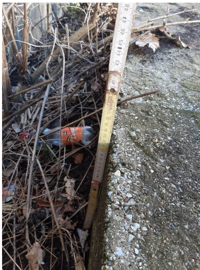
Figuur 11: aanduiding dikte betonplaat (© J. Verrijckt Bvba)
