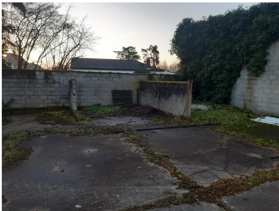
Figuur 10: Opslagkades (© J. Verrijckt Bvba)
