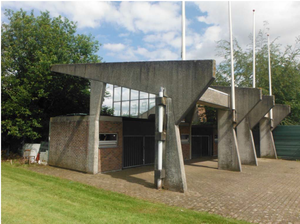
Fig. 3. Zicht op de bestaande ingang (foto: STRAMIEN).
