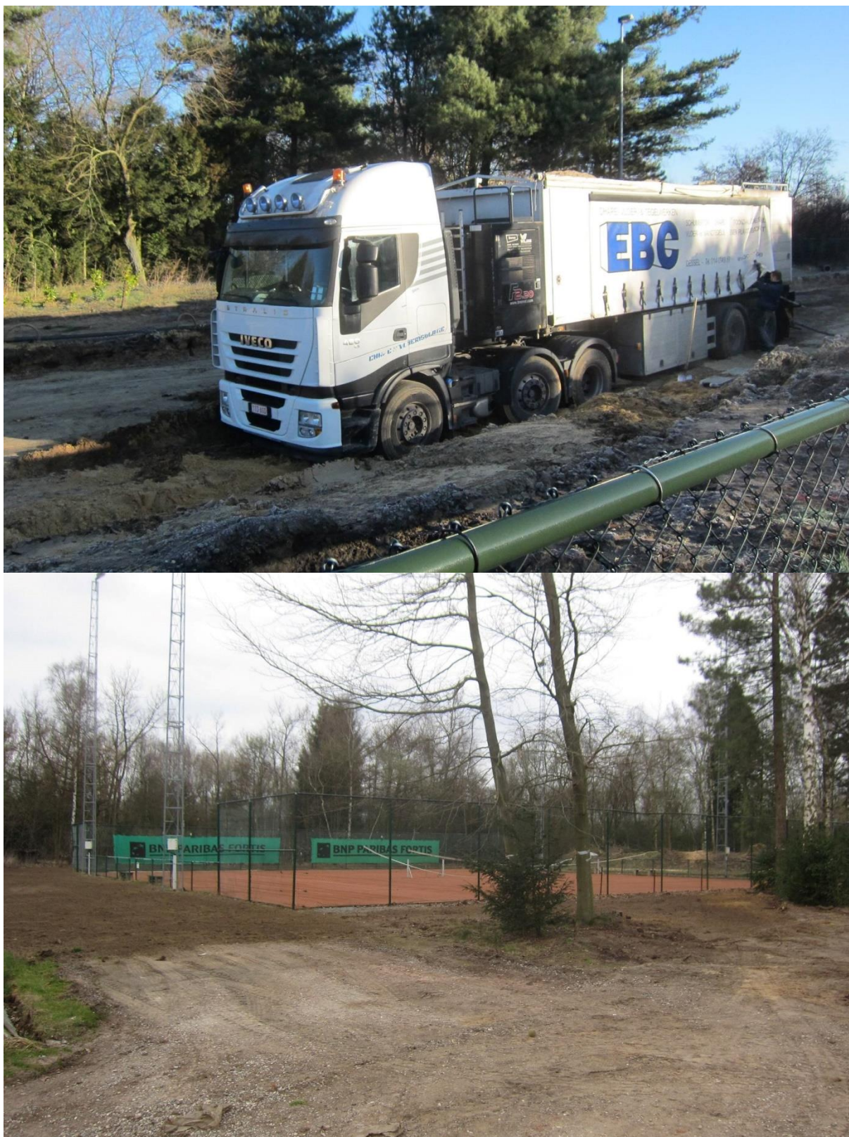
Figuur 7: Foto's genomen tijdens de aanleg van nieuwe verharding en groenvoorziening in het complex in 2014. 40
