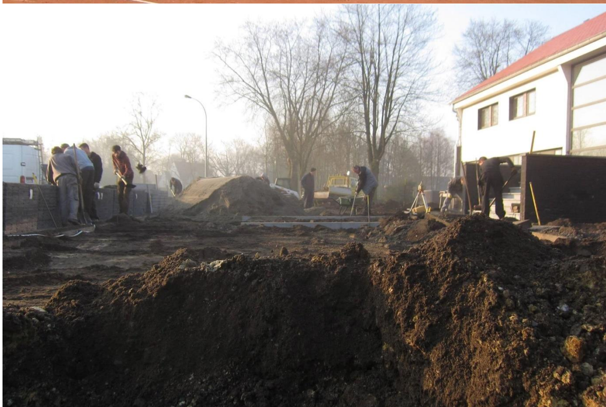
Figuur 6: Foto's genomen tijdens de aanleg van nieuwe verharding en groenvoorziening in het complex in 2014. 39
