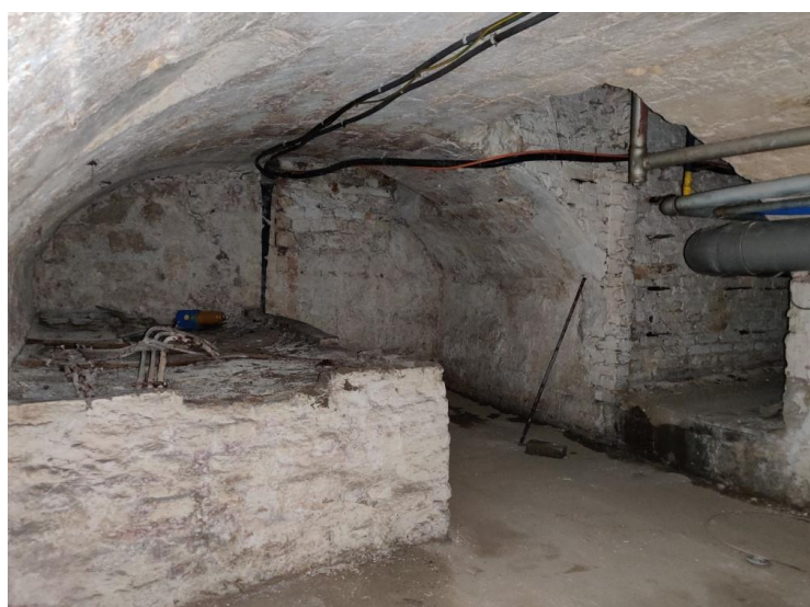
Figuur 8: Foto noordelijke kamer kelder
