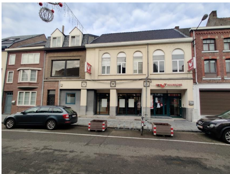
Figuur 6: Foto voorbouw – buitenaanzicht
