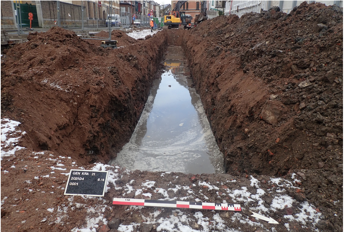
Figuur 4: Overzicht van proefsleuf 0001 vanuit het oostnoordoosten
