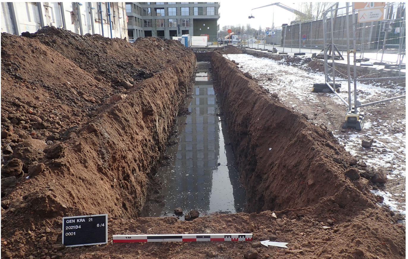
Figuur 5: Overzicht van proefsleuf 0001 vanuit het westzuidwesten
