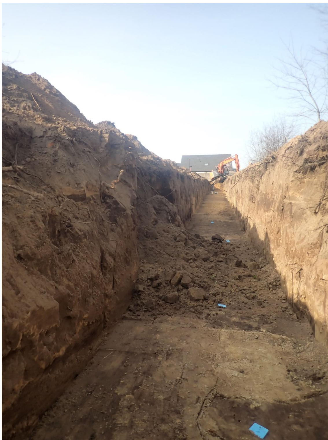
Figuur 6: Foto van ingestorte werkputwand ter hoogte van sporencluster in sleuf 5, ter illustratie (© J. Verrijckt)
