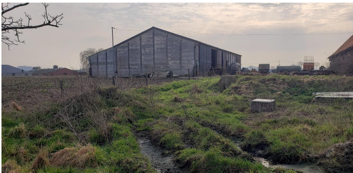
Figuur 2: Zicht op oostelijke loods en ophoging ter hoogte van bestaande bebouwing 6
