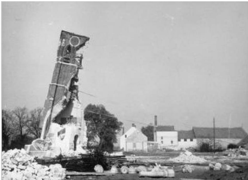
Figuur 42. Oorderen, sloop van de kerk (bron: ANONIEM, 1965a).
