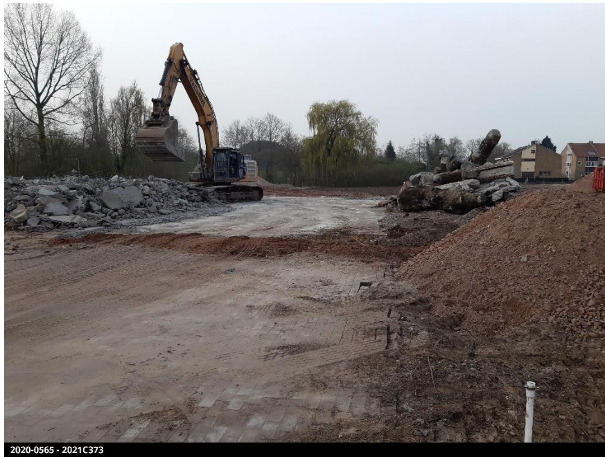
Figuur 4: Werfzone met stockage van grind en puin van de voormalige sloop centraal in het plangebied.
