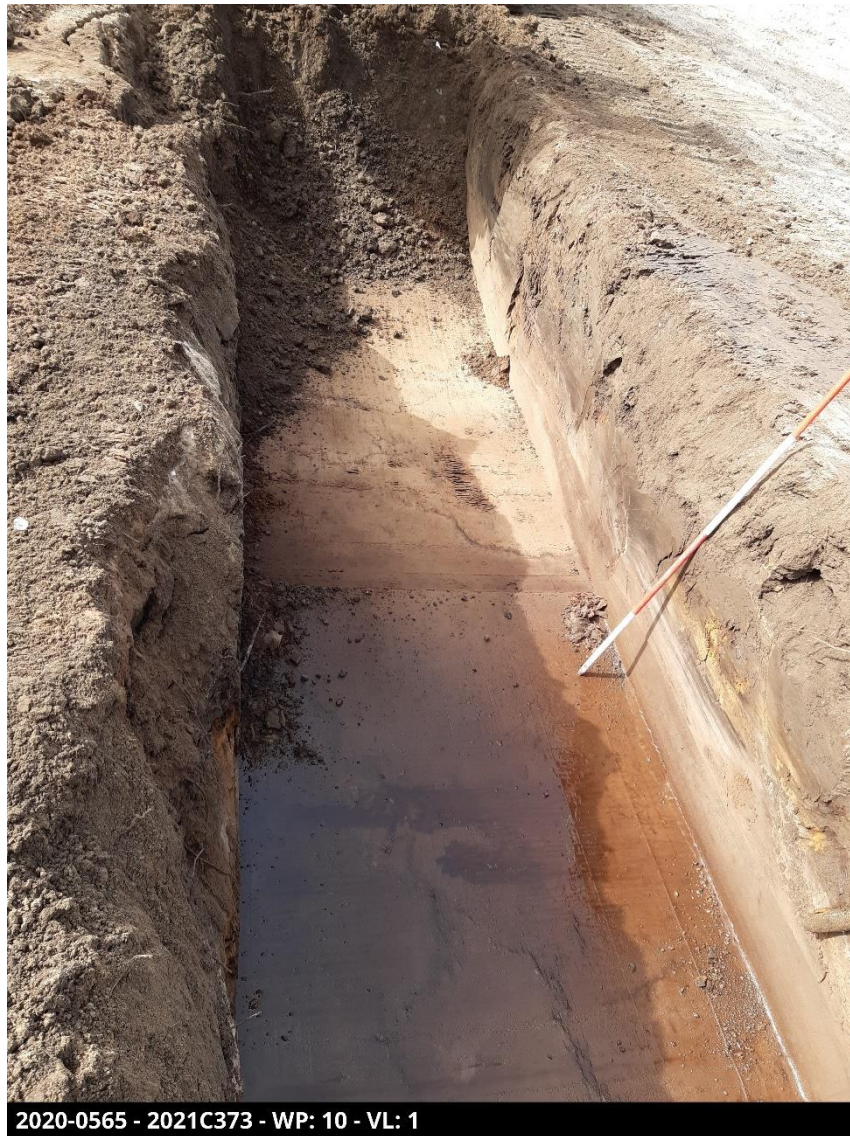
Figuur 47: Overzicht vlak 1 WP 10 met zicht op het sterk opkomend grondwater en instabiele profielwanden.
