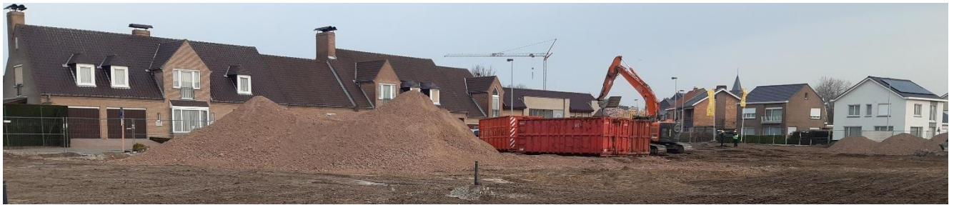
Figuur 6: Grindhopen en aanwezige containers in het westen van het plangebied ter hoogte van de straatkant.
