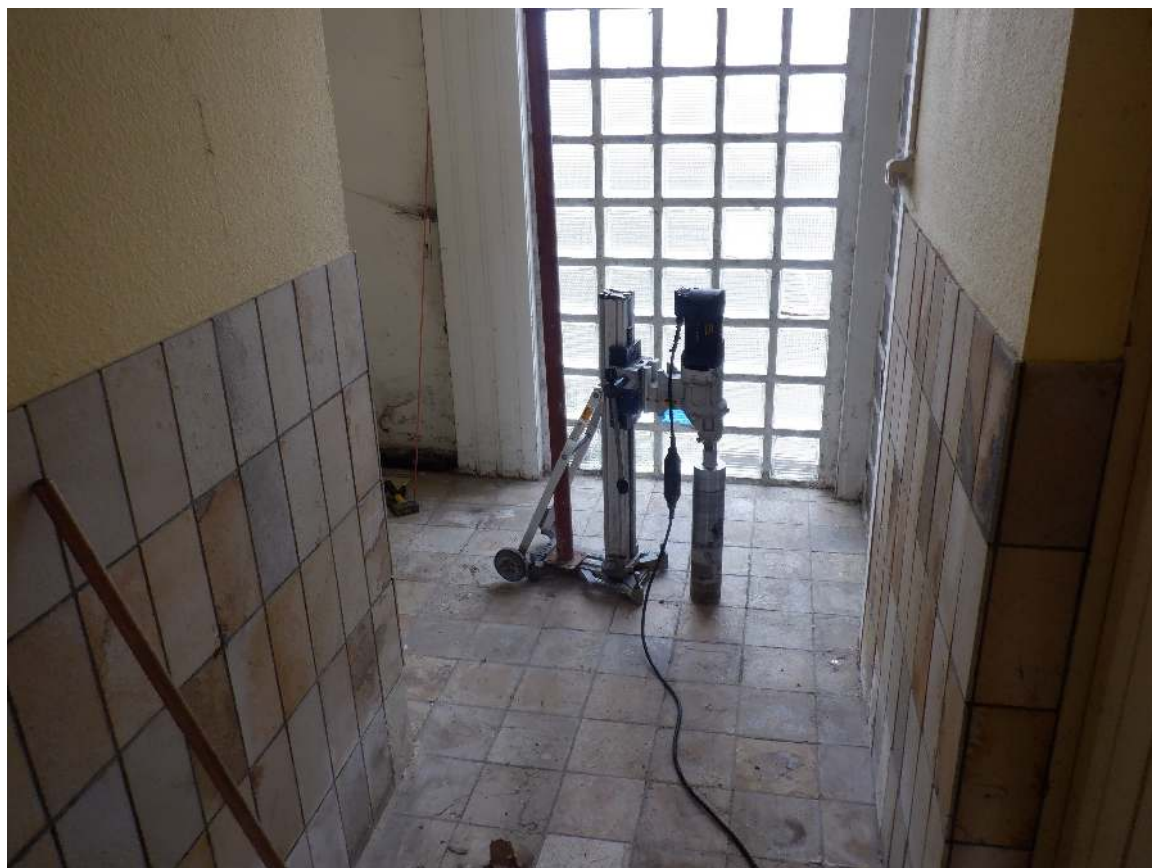
Afbeelding 3.4.5: Kernboormachine ter plaatse van boring 3.
