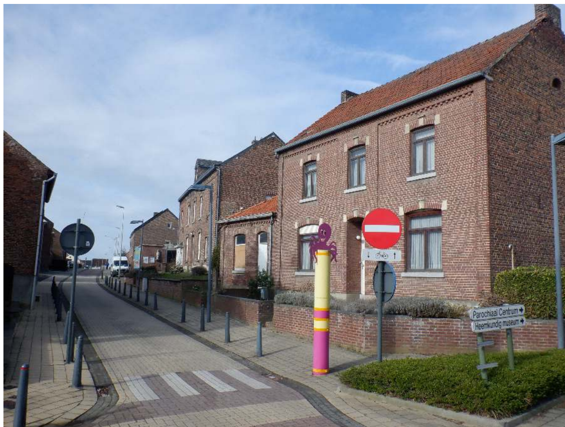
Afbeelding 5.1.3: Foto genomen vanaf het kruispunt van de Kloosterstraat met het Pater Vanweertplein met aan de rechterzijde de kapelanj die circa 1 m hoger ligt dan de weg en links daarvan het klooster. Beide gebouwen zijn duidelijk op een ophoogpakket gebouwd.
