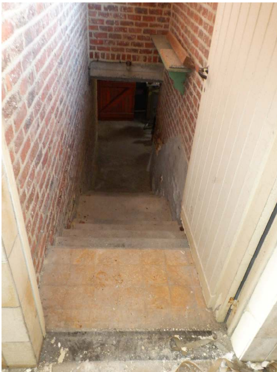
Afbeelding 3.4.4: keldertrap naar de kelder onder het te renoveren schoolgebouw.
