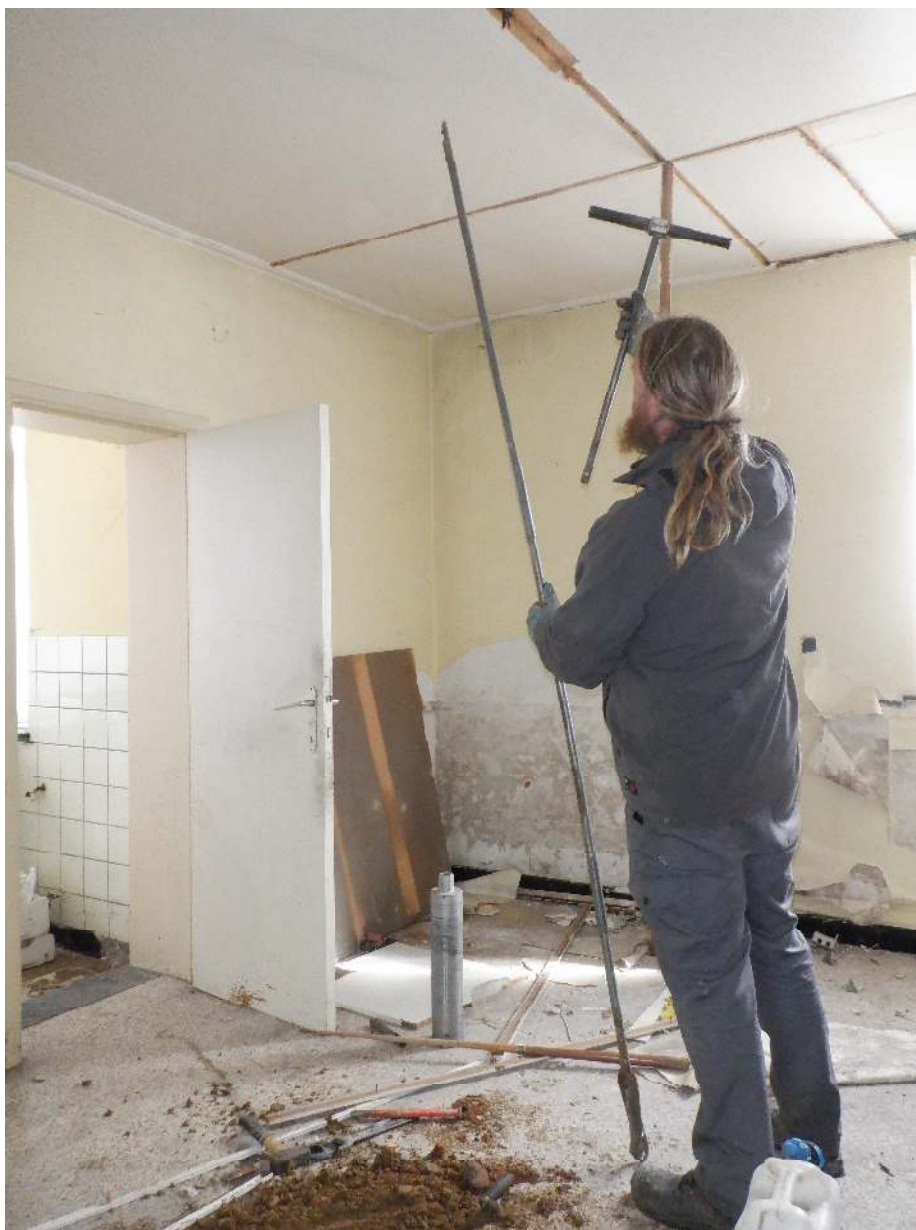
Afbeelding 3.4.7: Diepe boringen, zoals boring 4, in combinatie met een laag plafond, maakte dat boor steeds uit elkaar moest worden gehaald.
