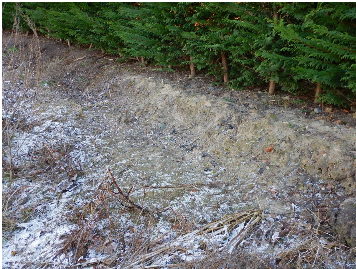
Figuur 20. Zicht op het afgegraven terrein en detailfoto van het hoogteverschil (©ADEDE bvba).
