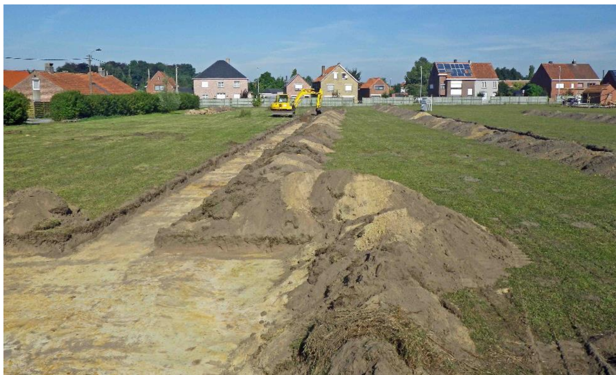
Figuur 29: Overzicht van het onderzoek langs de Miseriesstraat
