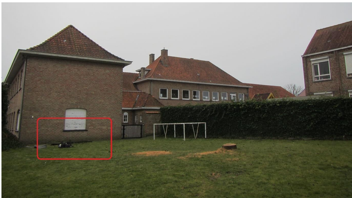
Figuur 34: Zicht op het terrein in westelijke richting, met aanduiding van het keldergat
