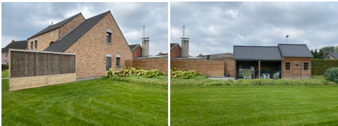
Afbeelding 3.3.1: Impressie bestaande toestand. Woning (links) en tuinhuis (rechts).
