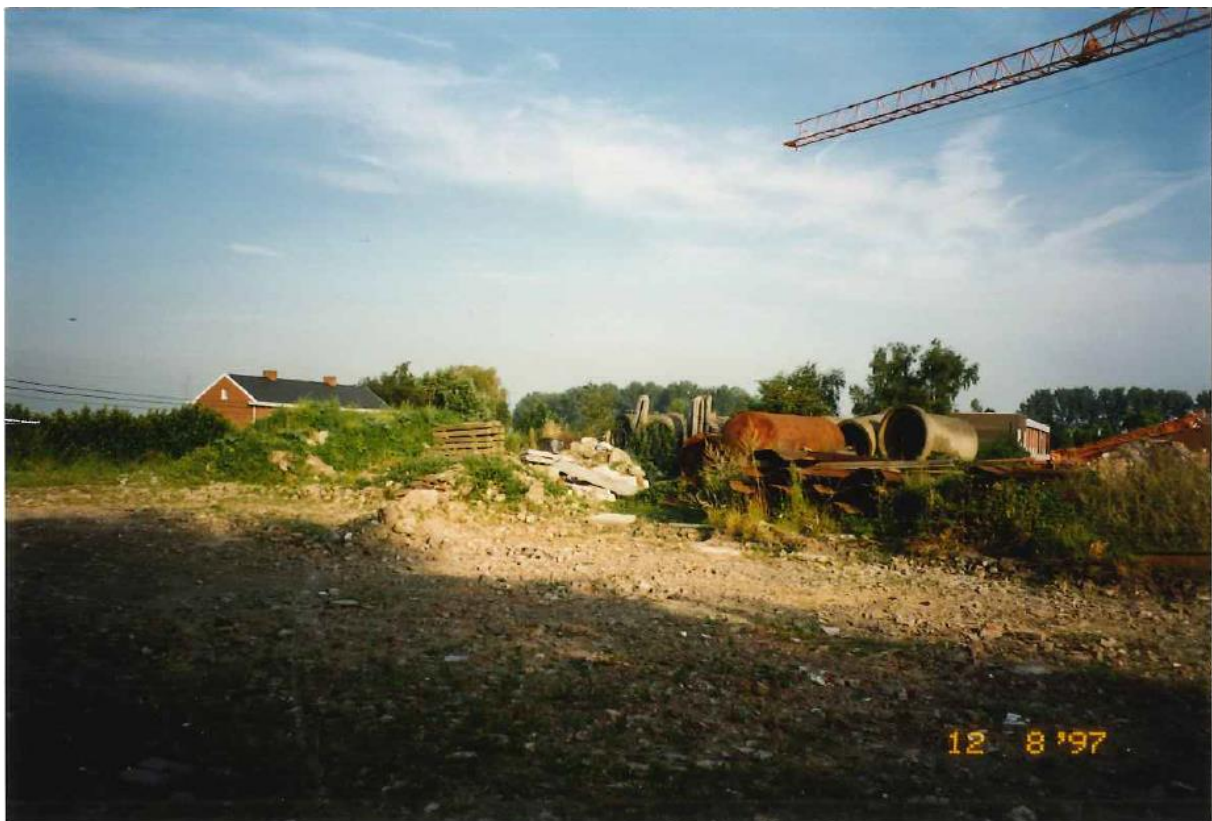
Figuur 1. Zicht op de open ruimte voor stockage van bouwmaterialen (©opdrachtgever).
