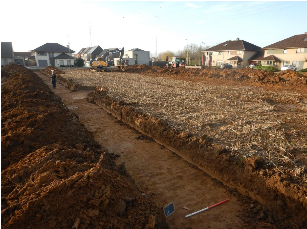
Figuur 6: De zuidelijke zone tijdens het terreinwerk.
