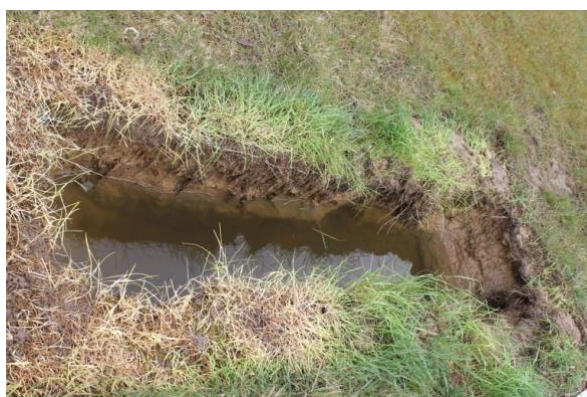
Figuur 38: Testput ter locatie van de riolering (foto: Gerrit Borms)
