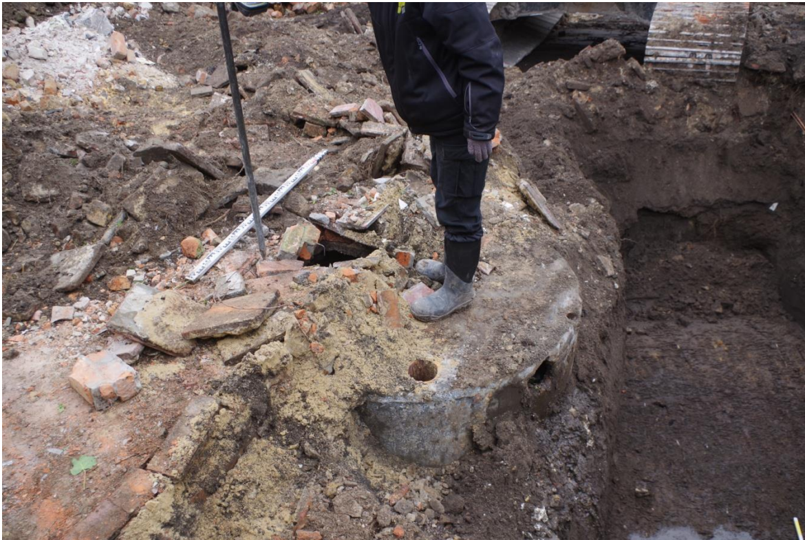
Figuur 17 Betonnen septische put ter hoogte van proefsleuf 1.
