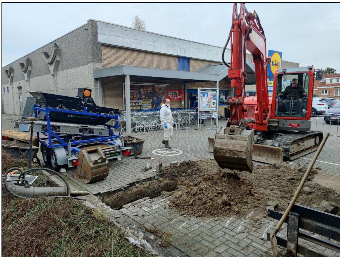
Figuur 6: Aanleg van profielputten ter hoogte van bodemsleuven op de parkingzone (ABO nv 2021)
