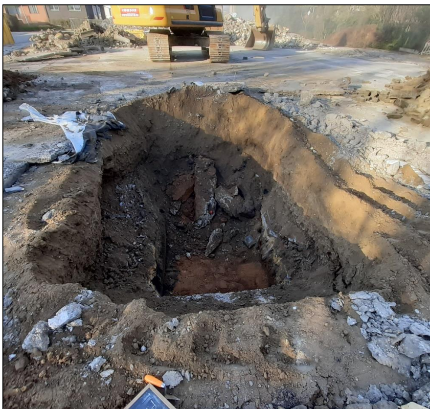
Figuur 7: Aanleg van de profielputten onder de vloerplaat na de sloop van het winkelgebouw (ABO nv 2021)
