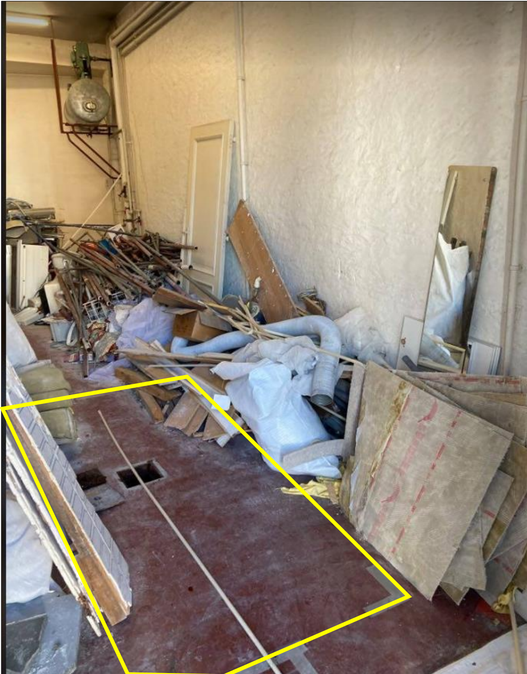
Figuur 5: Bestaande garage. De contour van de put is afgeplakt met tape en is hierboven aangeduid met een gele contour. Langs de muren zijn talrijke buizen waar te nemen.
