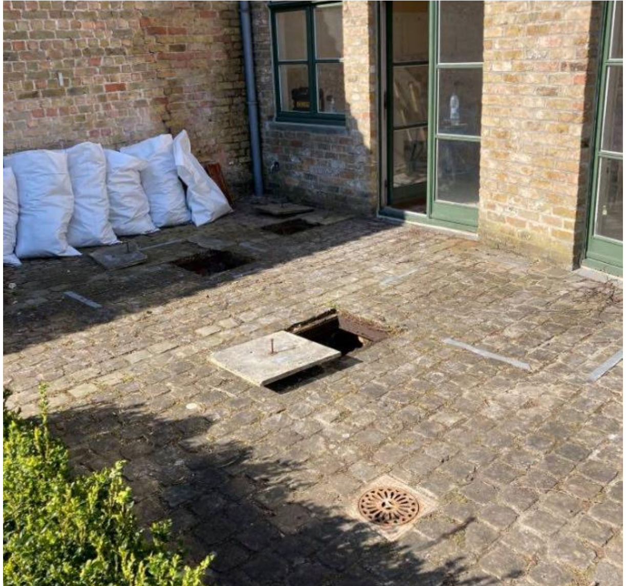
Figuur 6: Putten op de bestaande terras (zelfgenomen foto tijdens plaatsbezoek).
