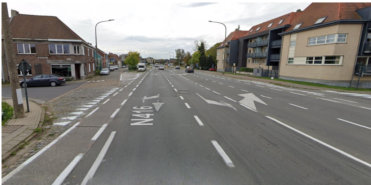
Figuur 7: Zicht vanuit het noordelijk uiteinde van het plangebied (Accaciastraat) richting zuiden, situatie oktober 2020 (bron: Google 2021)
