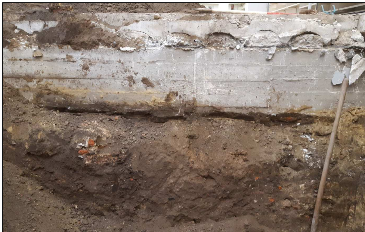
Figuur 55: Zicht op dwarse funderingsbalk in werkput 1
