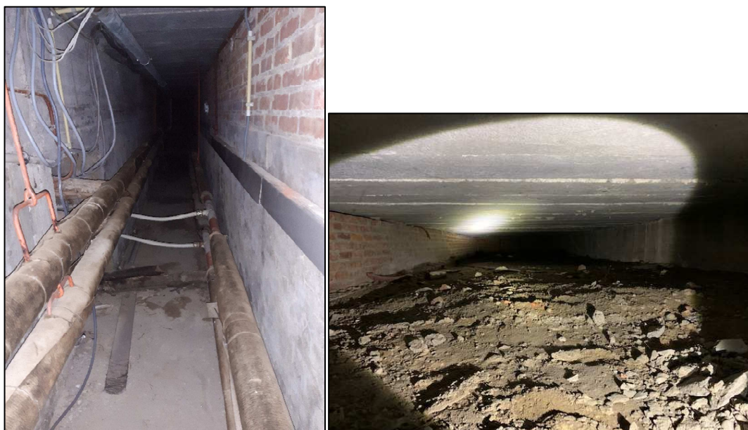
Figuur 31: Zicht op caniveau met leidingen (links) en zicht vanuit caniveau op dwarse funderingsbalk, vloerplaat grote leeszaal en holle ruimte onder vloerplaat.
