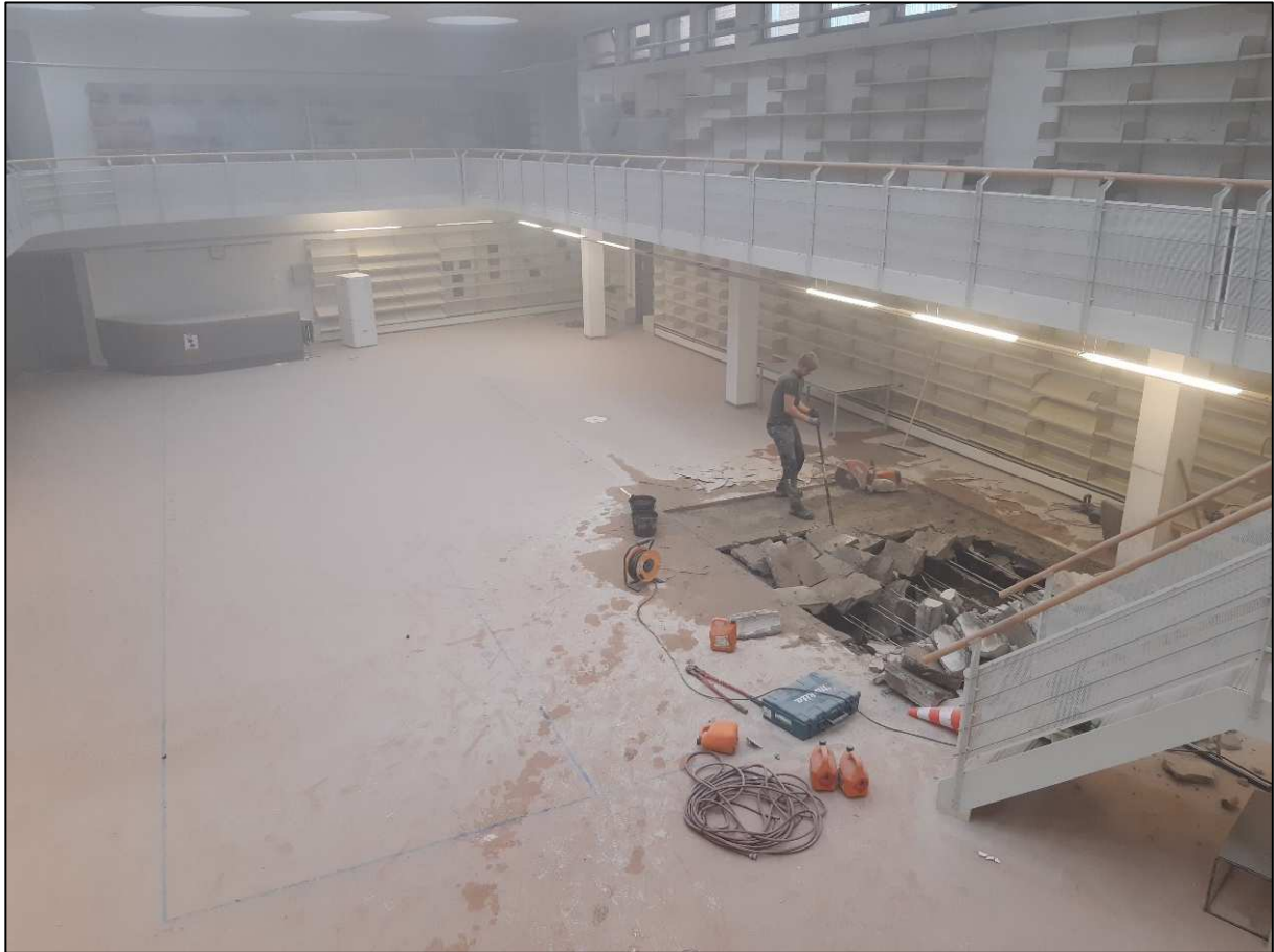
Figuur 22: Stofvorming bij het uitslijpen en opbreken van werkput 1.
