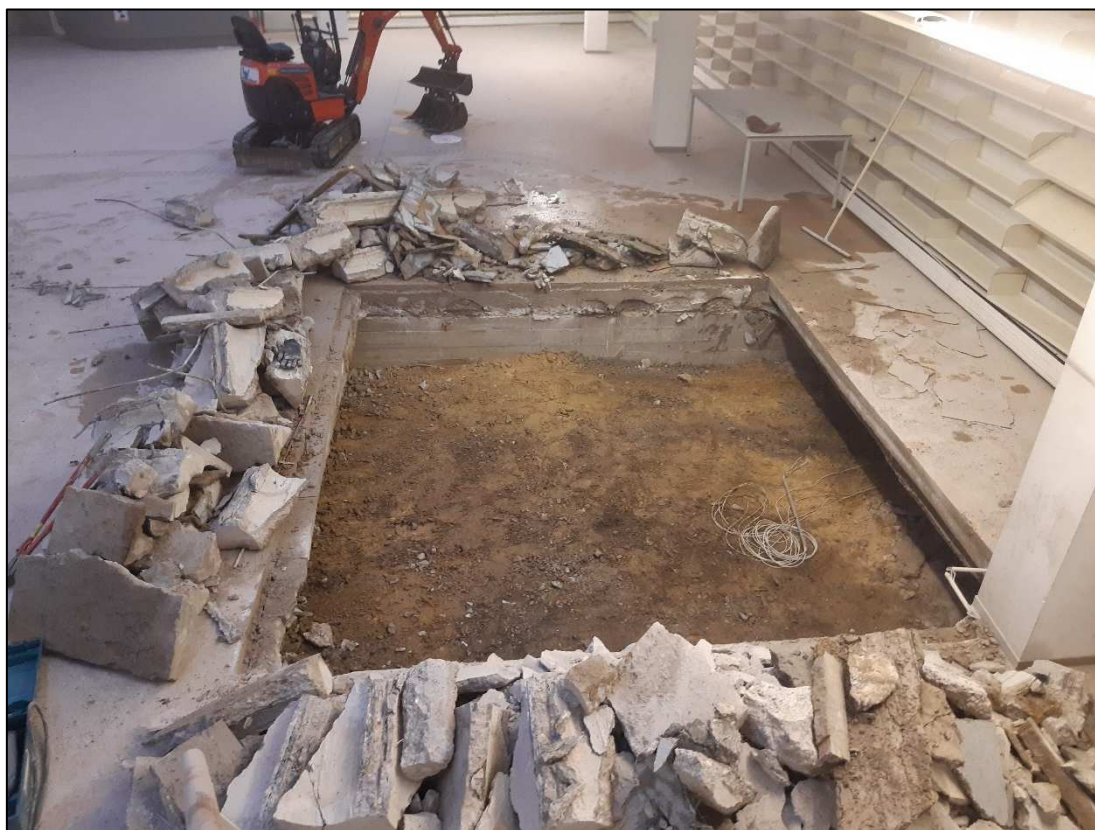
Figuur 24: Overzicht werkput 1 na uitbreken vloerplaat en voor aanvang archeologisch gravend werk.
