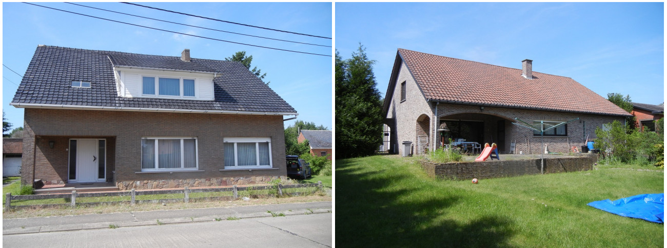
Fig. 1.7: Zicht op de huidige bebouwing (anno 2016).
