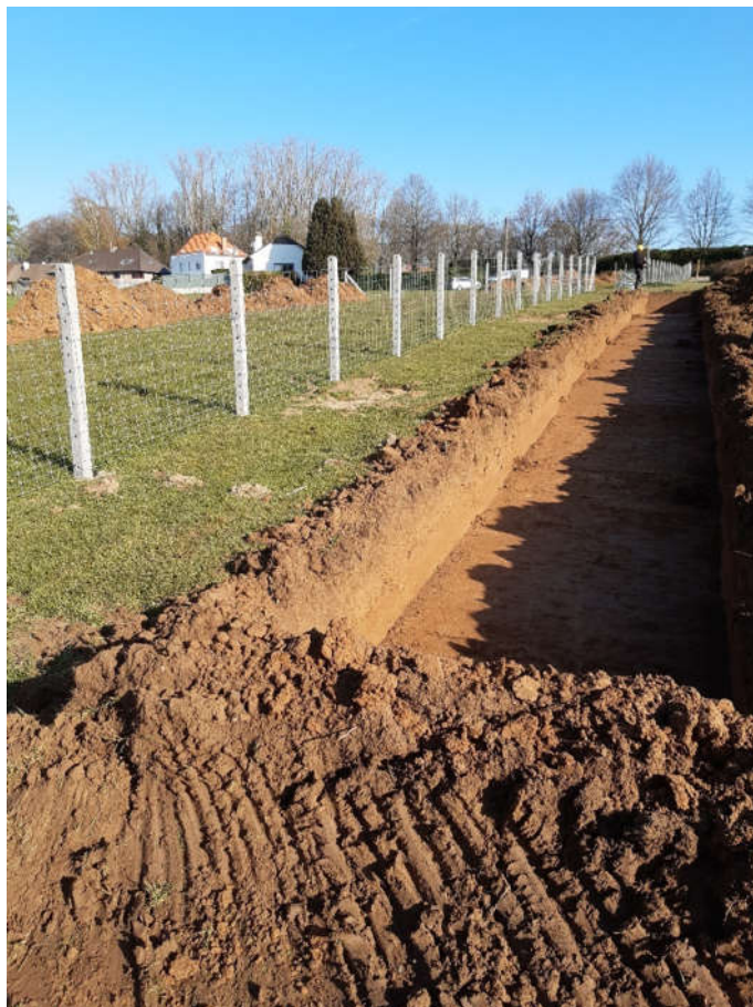
Figuur 4: Hekwerk naast werkput 4
