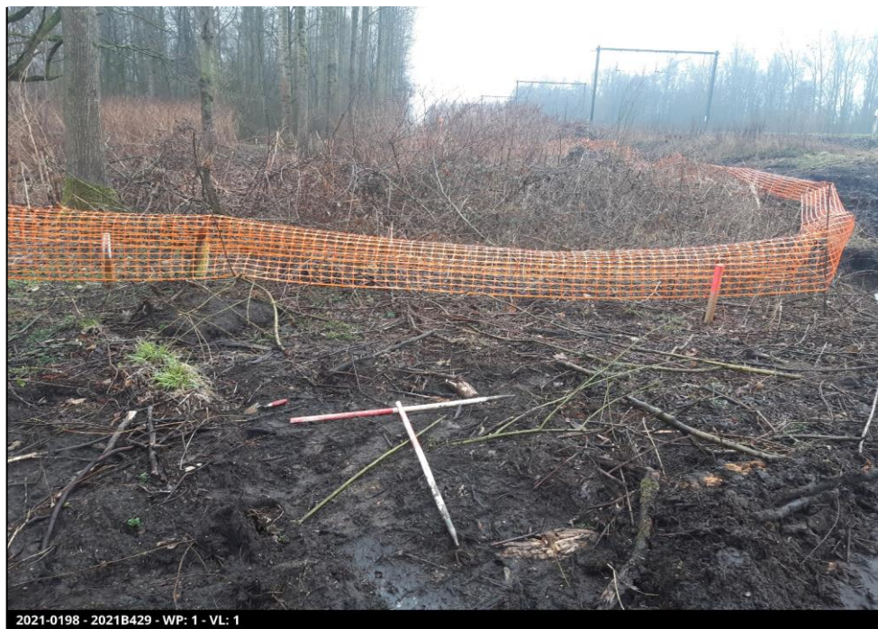
Figuur 20: Nog te verwijderen Japanse duizendknoop in werkput 1.
