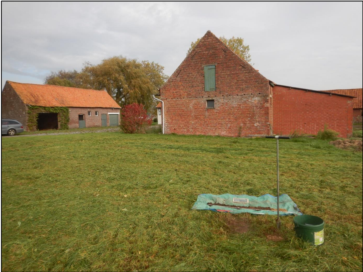
Figuur 2 Zicht op het plangebied voor de bovengrondse sloop van de stallen en tijdens het landschappelijk booronderzoek.
