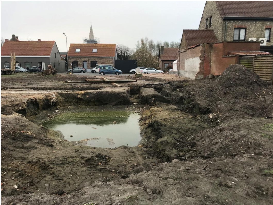
Figuur 22: Zicht op één van de putten gevuld met water en de sleuven veroorzaakt door het uitbreken van de fundering.
