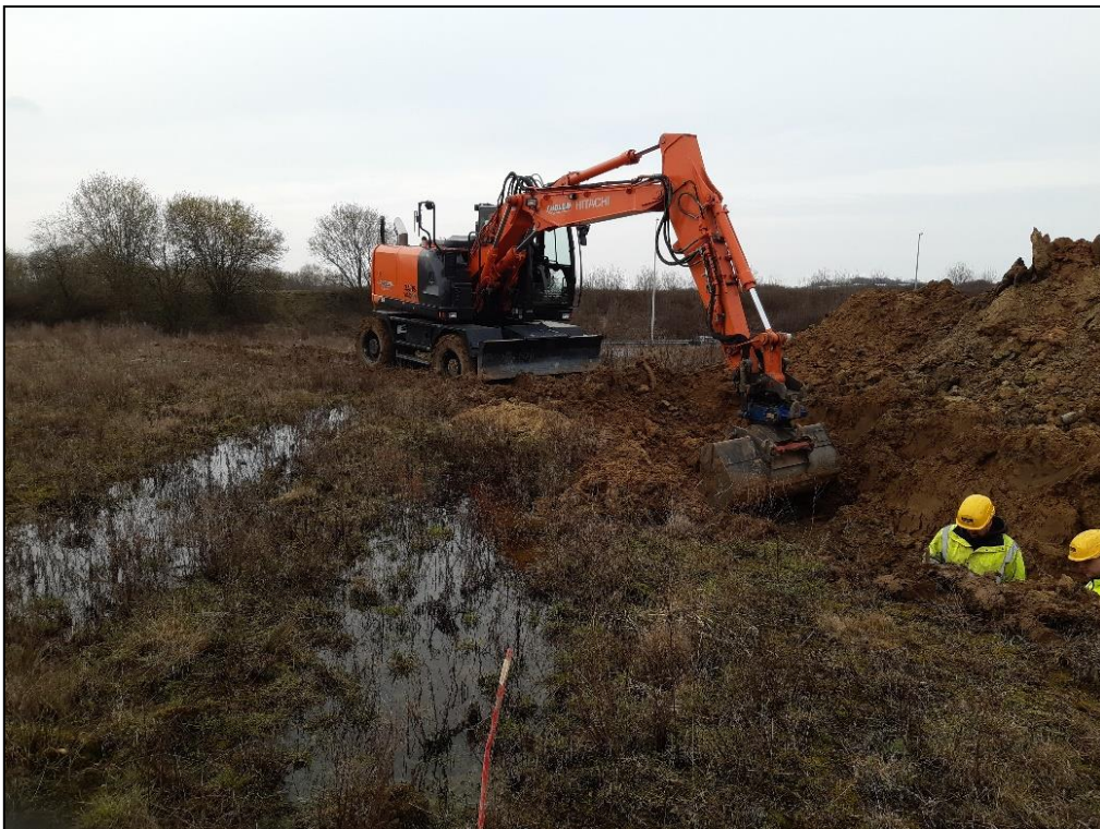
Figuur 4: Moeilijkheden op het terrein tijdens uitvoer nota Tongeren Carpoolparking (ID 18399): Water op het oppervlak waardoor een sleuf moesten uitwijken
