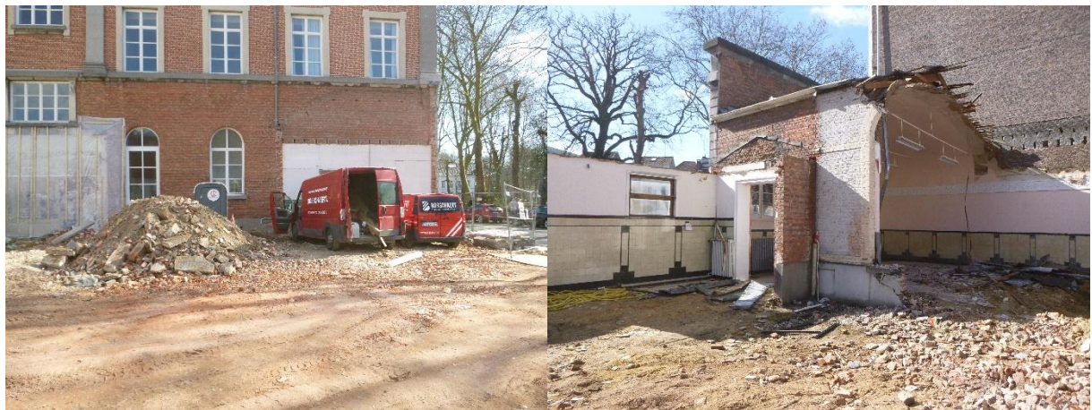
Figuur 25: Omgevingsfoto's ter hoogte van BP5, genomen in zuidoostelijke (links) en zuidwestelijke richting (rechts).
