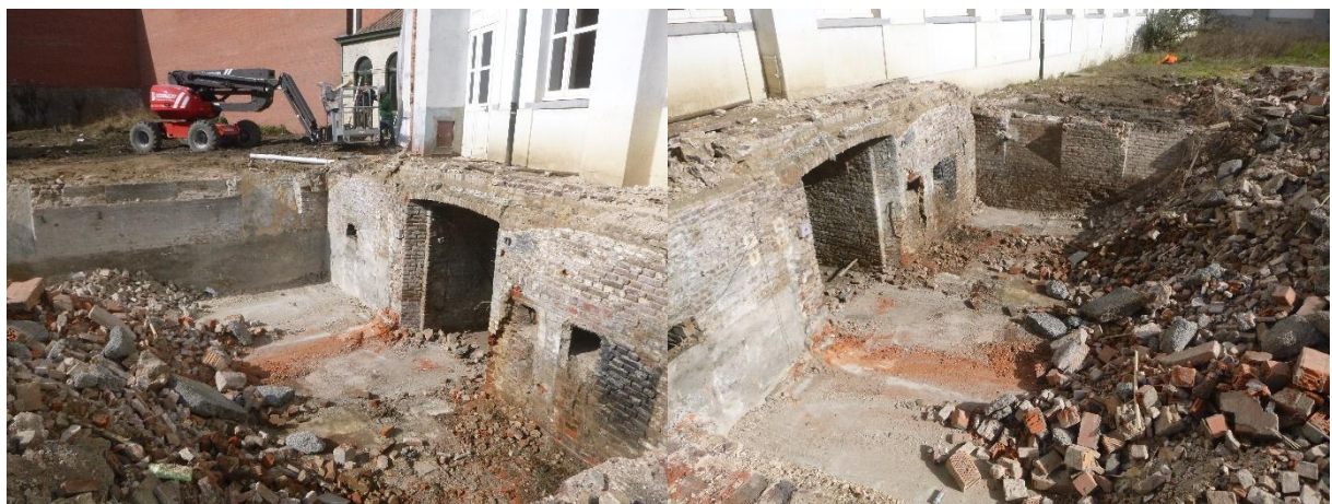
Figuur 26: Omgevingsfoto's met zicht op de noordelijke bestaande kelder. De foto's zijn genomen vanuit zuidoostelijke (links) en zuidwestelijke richting (rechts).
