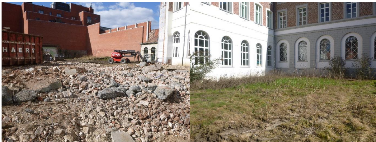
Figuur 22: Omgevingsfoto's ter hoogte van BP2, genomen in noordwestelijke (links) en noordoostelijke richting (rechts).
