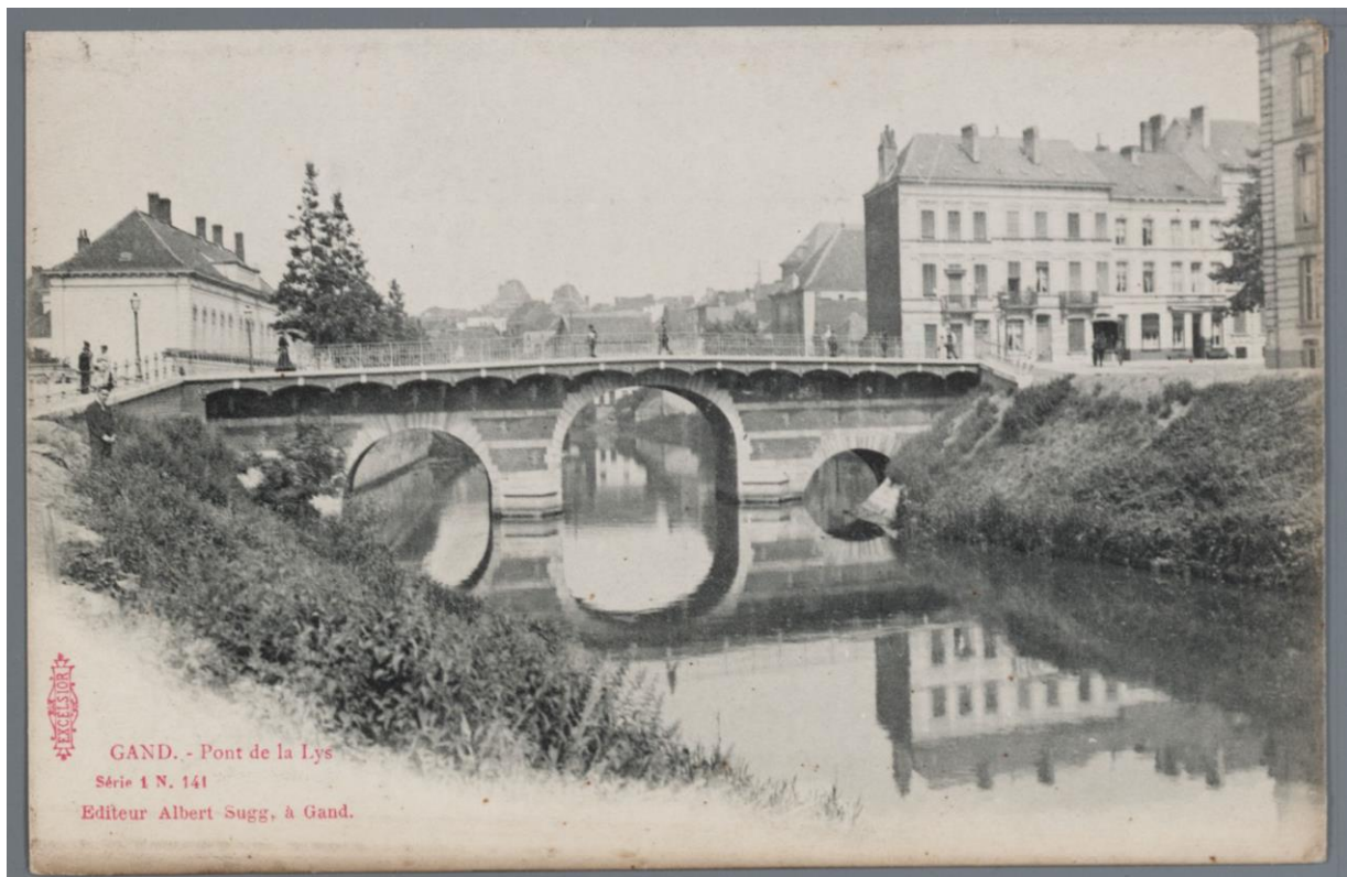
Figuur 12. Zicht op de Verlorenkostbrug 12
