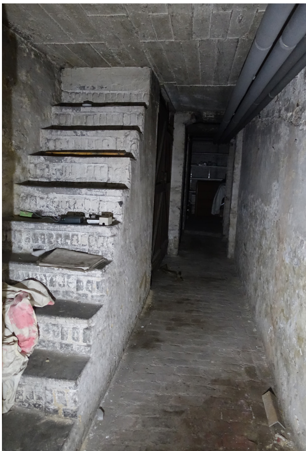
Zicht op één van de doorgangen.
