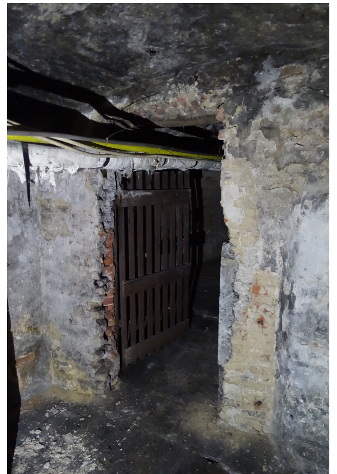
De doorgang naar kelder 2 in de noordelijke wand.
