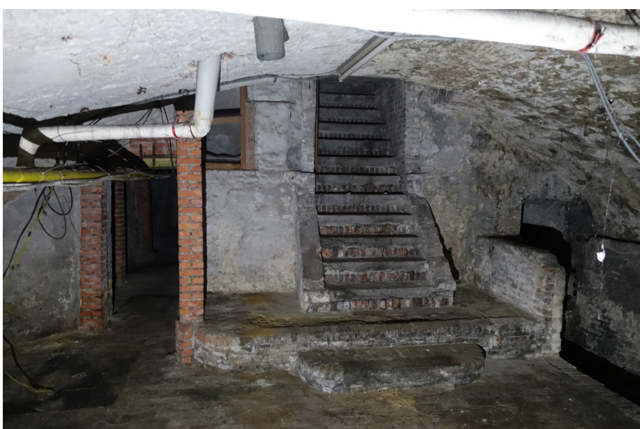
De noordelijke wand met links doorgang naar kelder 3, centraal de trap en rechts de bak.
