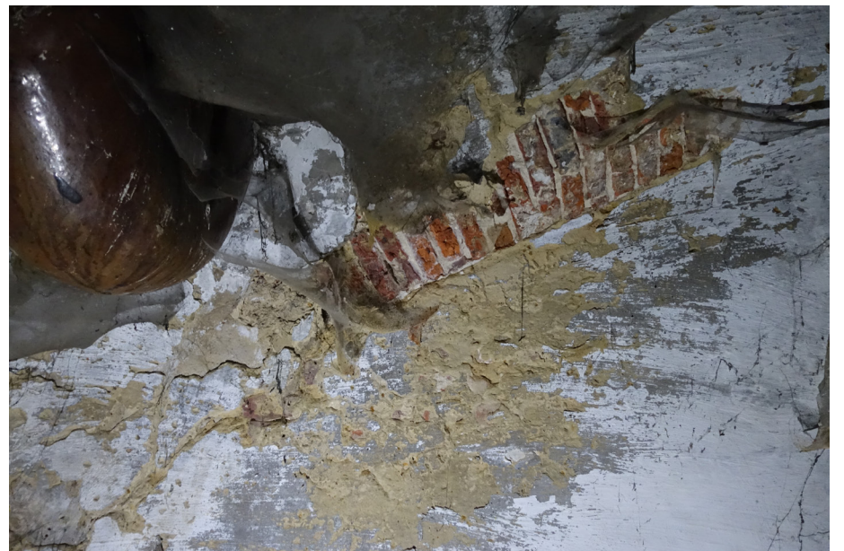
Zicht op de boog in de westelijke wand.
