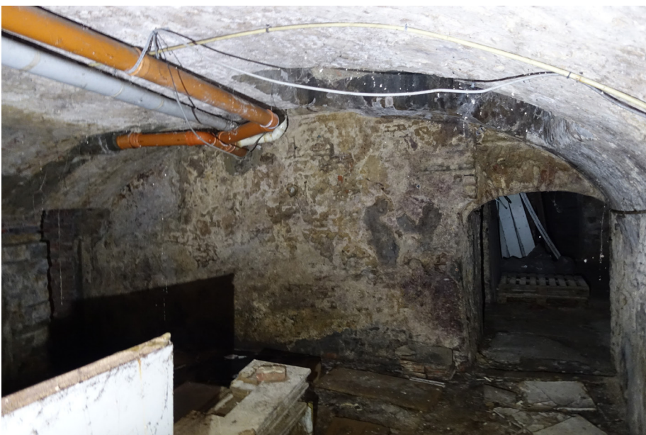
Zicht naar het zuiden met de doorgang naar kelder 2.
