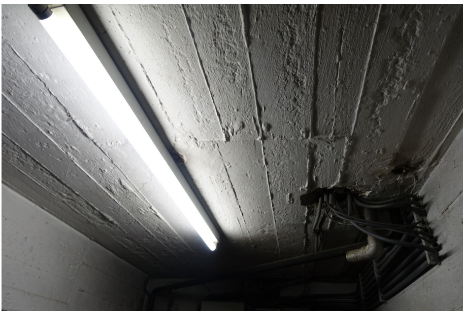
Betonnen plafond in de eerste ruimte.
