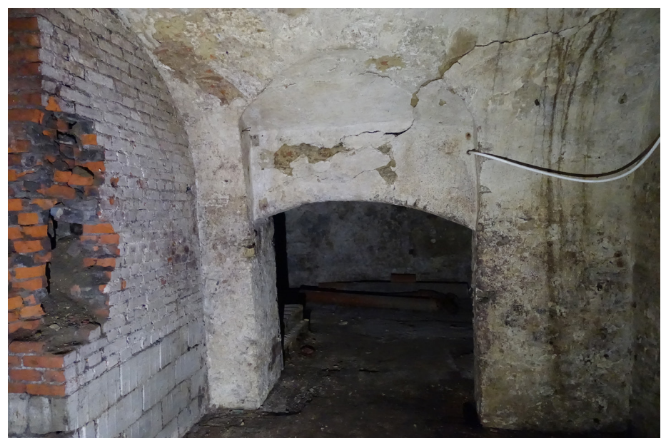
Doorgang naar de westelijke kelderruimte.
