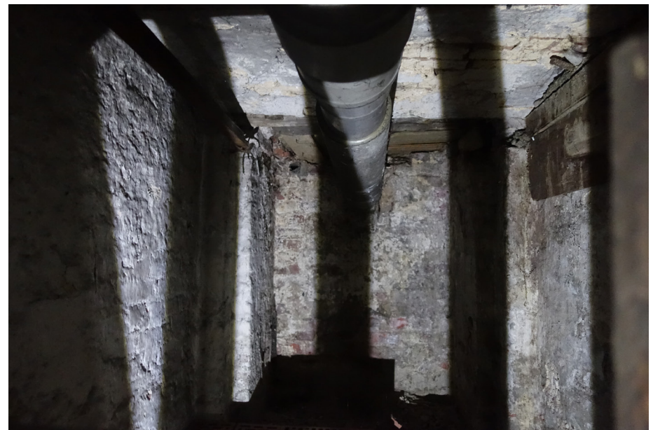
Zicht op de tweede ruimte, naar het noorden toe.
