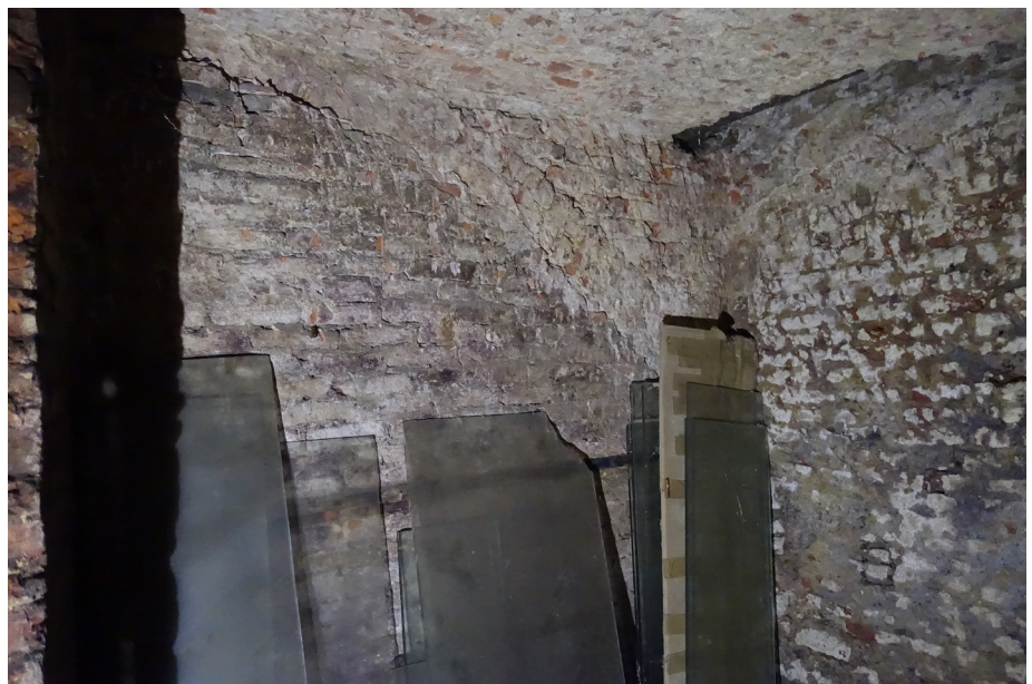
Zicht naar het noorden, wand tussen zuidelijke ruimte en oostelijke ruimte met later dichtgemaakte wand.
