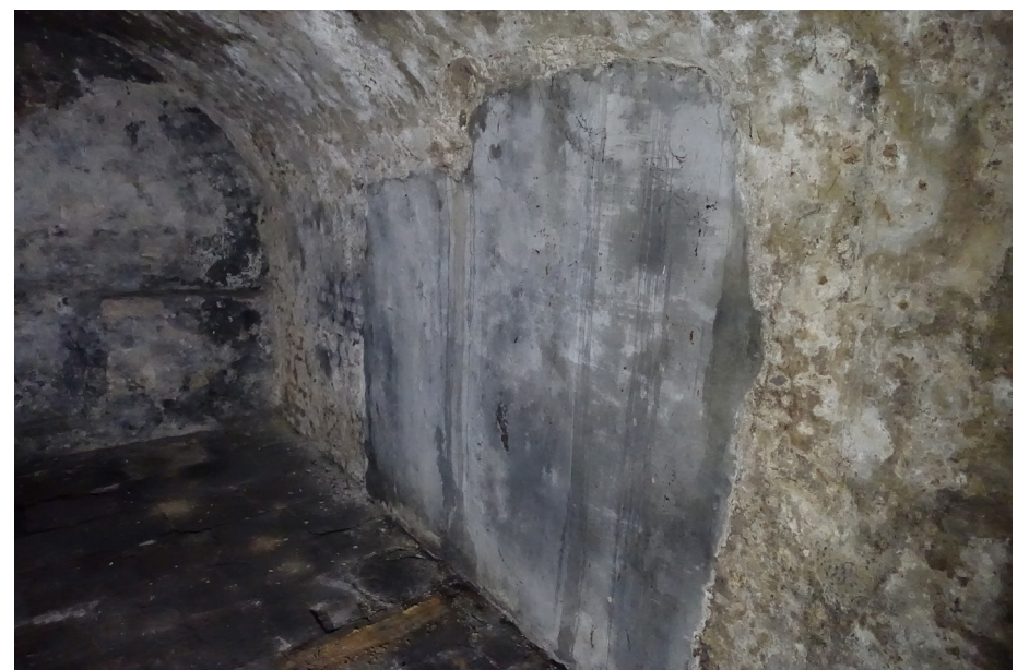
De oostelijke wand met de gedichte opening die mogelijk toegang gaf tot de open ruimte op het gelijkvloers.
