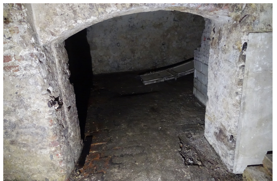
Doorgang naar de oostelijke kelderruimte.
