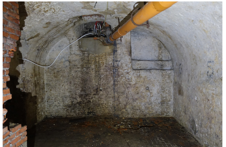
Oostelijke kelderruimte naar de noordzijde toe met dichtgemaakt kelderraam.
