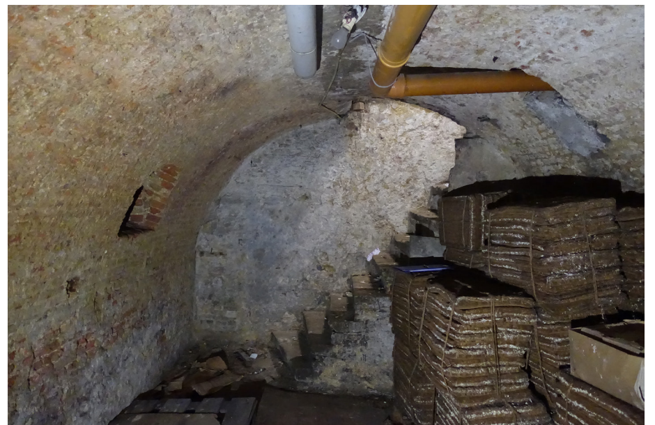
Zicht naar het noorden met de trap in de noordoostelijke hoek.
