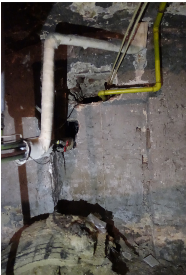
Zicht op de gedichte doorgang naar de kelder van Oude Beurs 37.
