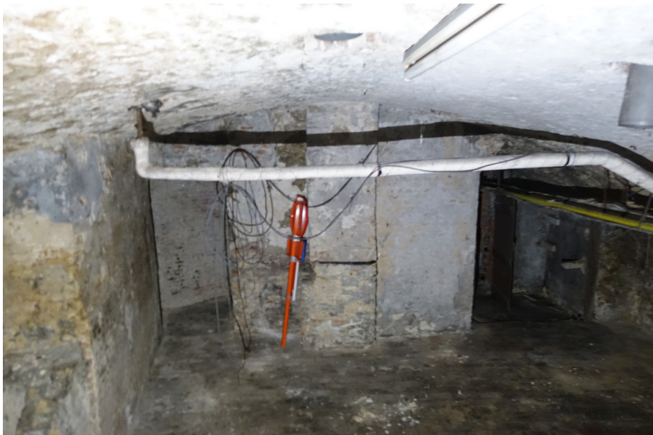
Zicht naar het zuiden met in de linkerhoek de waterput (niet zichtbaar op foto) en rechts de doorgang naar kelder 1.
