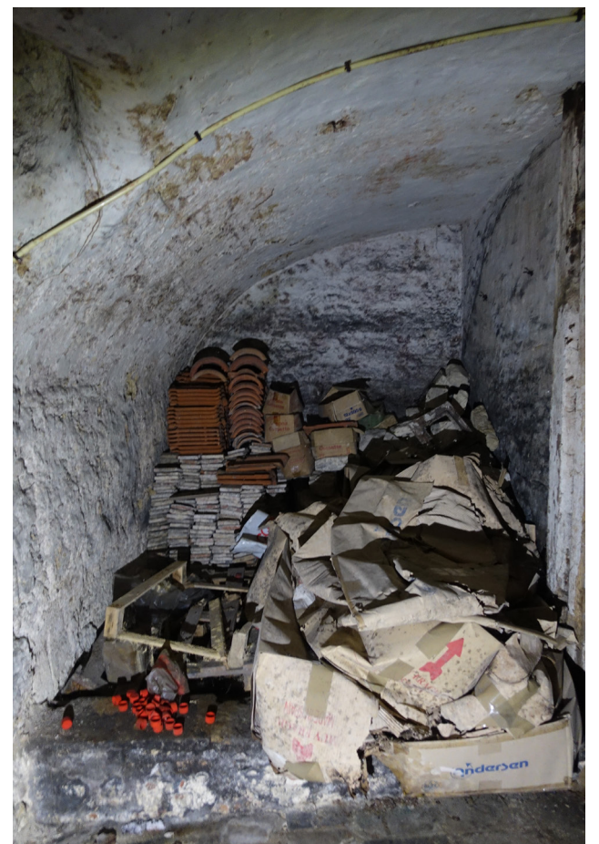
Zicht naar het westen in de zuidelijke ruimte.
