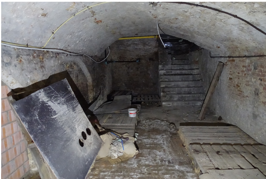
Westelijke kelderruimte naar de straatzijde toe. Links zijn de gordelbogen te zien en aan de straatzijde de trap.
