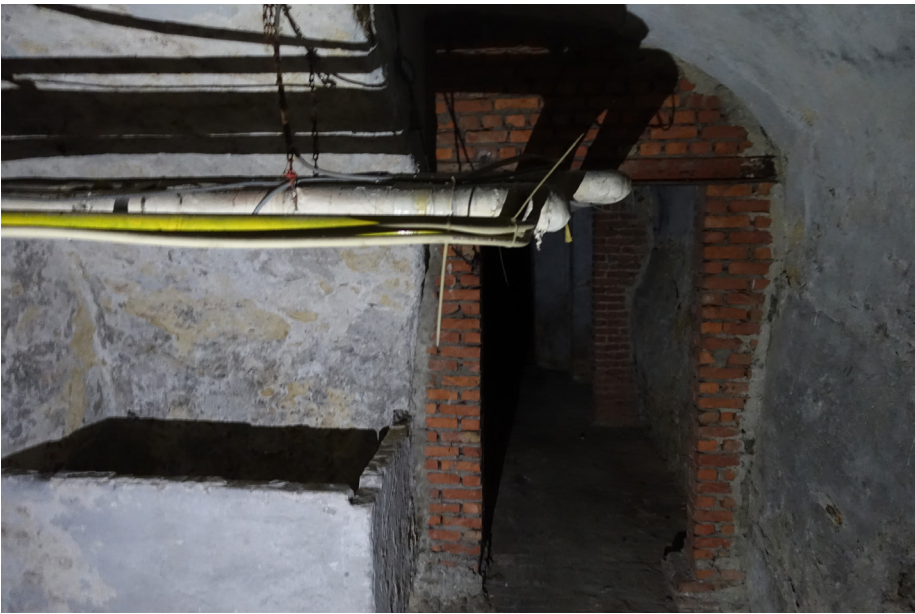
Zicht op de zuidelijke wand met links een bak en rechts de doorgang naar kelder 3.
