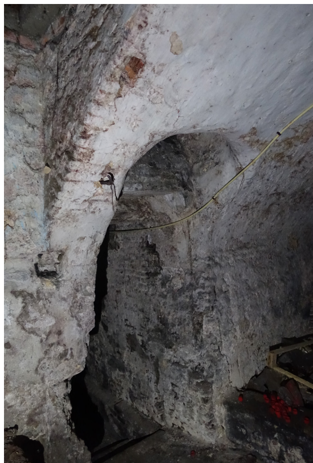
Latere doorgang naar kelder 3.
