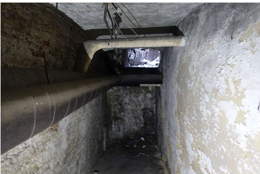
Zicht richting de straat met het keldergat in de noordelijke ruimte.
