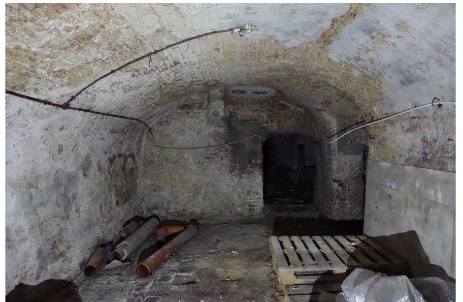
Westelijke kelderruimte naar de noordzijde (kelder 3) toe. In de noordelijke wand de doorgang naar kelder 3 en het dichtgemaakte kelderraam.
