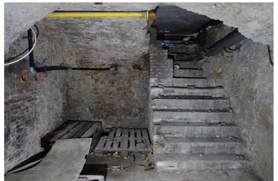
Bakstenen trap met tredes in natuursteen die uitgaf op de straat. Deze toegang werd later gedicht.
