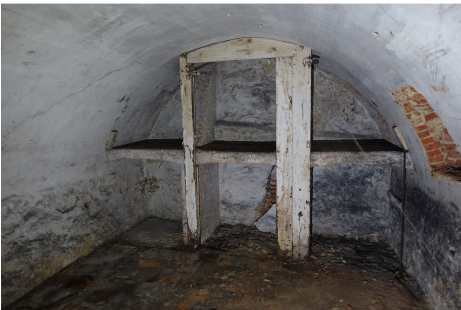
Zicht naar het noorden in de westelijke kelderruimte.
