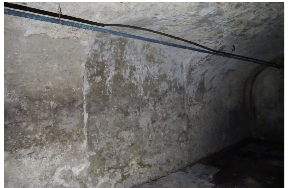
Zicht op de muur tussen beide ruimtes met de dichtgemaakte opening.
