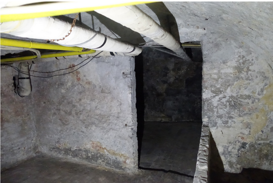
Zicht op de oostelijke wand met deuropening naar de oostelijke ruimte.
