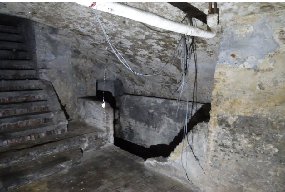
Zicht naar het noordoosten met links de trap en rechts de bak.
