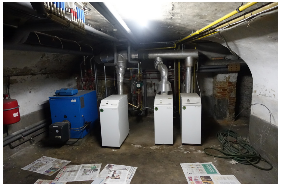
Zicht naar de noordelijke wand met rechts één van de doorgangen.
