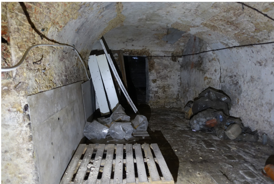
Westelijke kelderruimte naar de zuidzijde toe. Achteraan de doorgang naar kelder 1.
