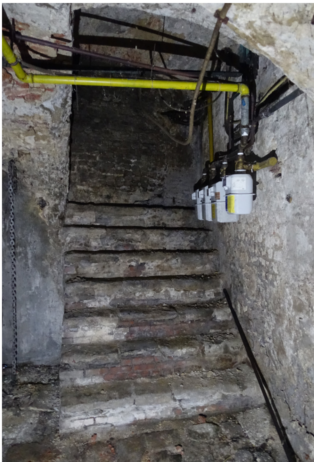
Zicht op de zuidelijke wand met de trap naar de straat toe.
