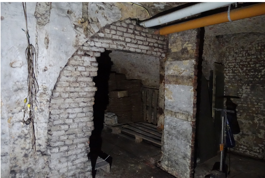
Zicht naar het noorden, wand tussen zuidelijke ruimte en oostelijke ruimte met later deels dichtgemaakte wand.
