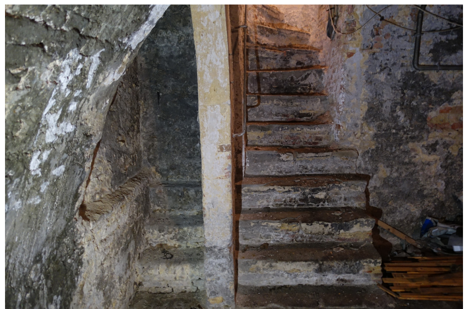
Zicht op de trap met links nog drie tredes van een oudere trap.
