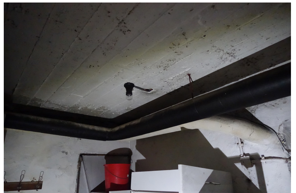
Betonnen plafond in de tweede ruimte.
