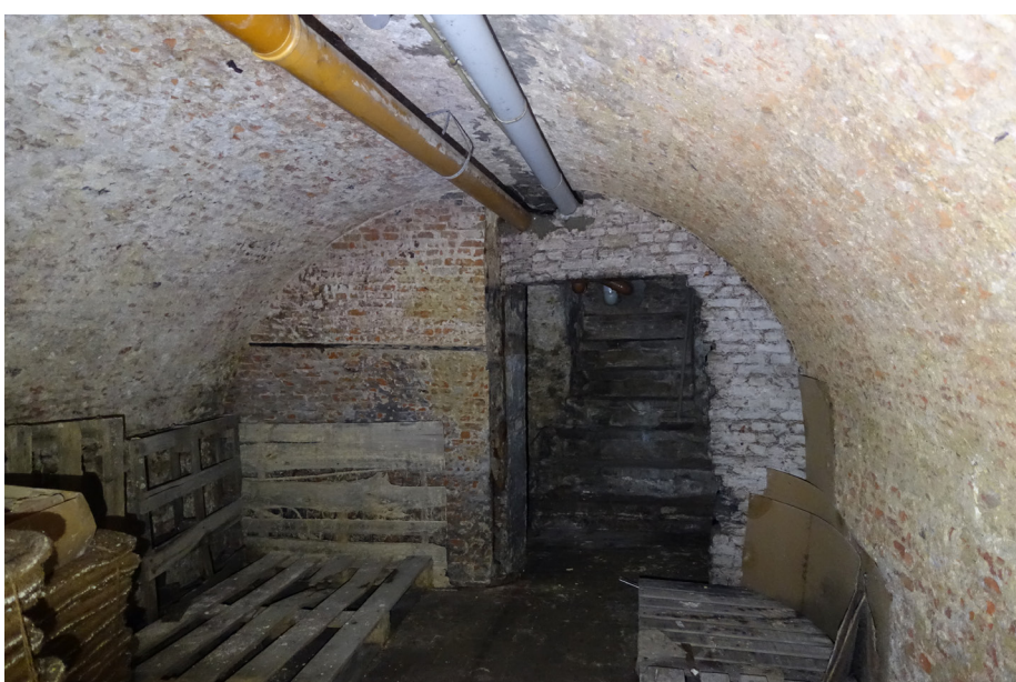
Zicht naar het zuiden met de later gedichte wand en deuropening naar de zuidelijke ruimte.
