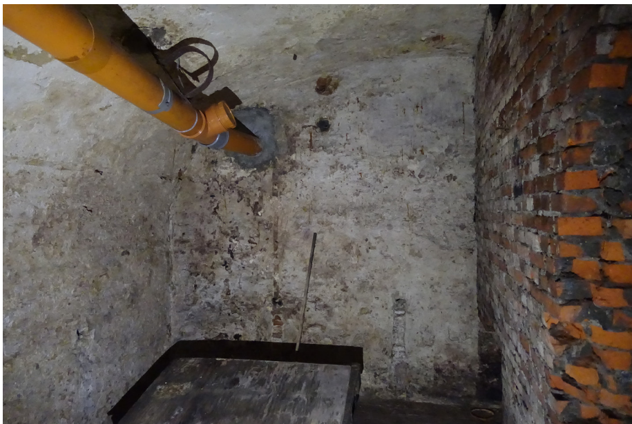
Oostelijke kelderruimte naar de zuidzijde toe met rechts bakstenen constructie.
