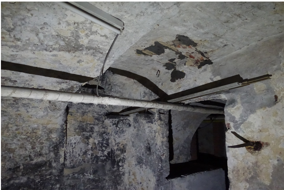
Zicht op de gedichte opening in de oostelijke ruimte.
