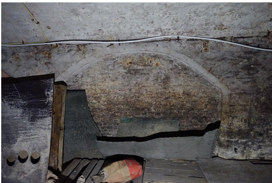
Zicht op één van de gedichte bogen op pijlers met natuurstenen hoekstenen.
