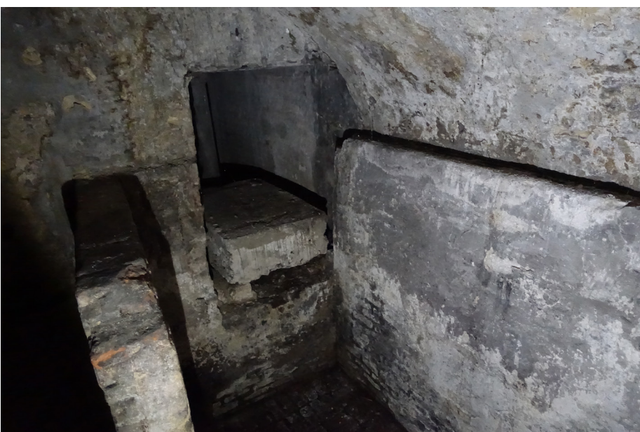
Zicht naar het noorden vanaf de bak met latere doorbreking naar kelderruimte 3.
