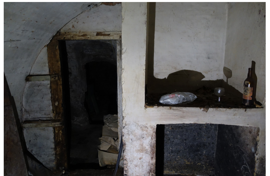
Zicht naar het zuiden in de westelijke kelderruimte.
