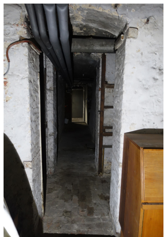
Zicht naar het oosten vanuit de meest westelijke ruimte.
