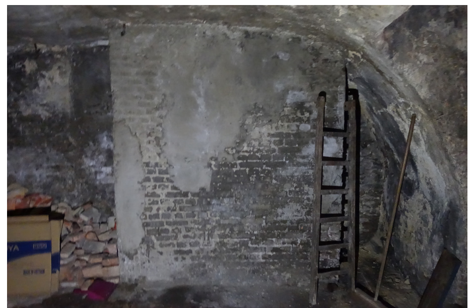
Zicht op de constructie tegen de oostelijke wand.
