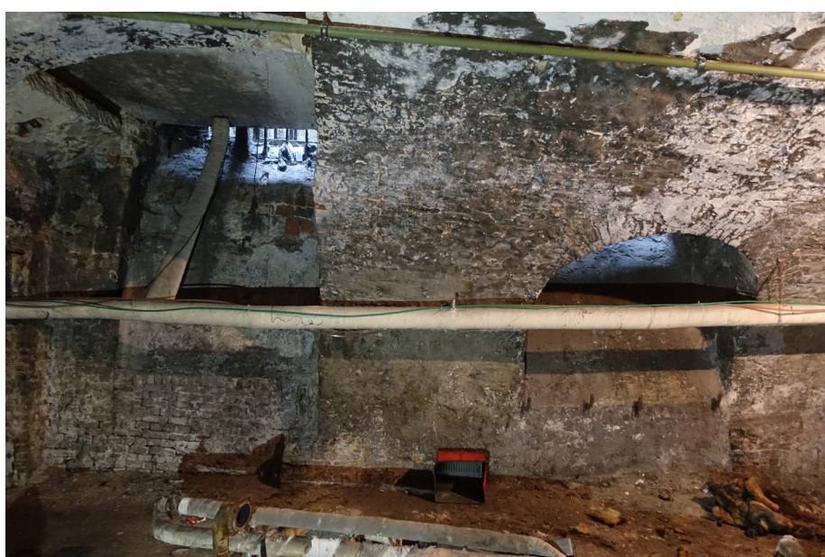
Zuidelijke wand met de twee kelerगतen.
