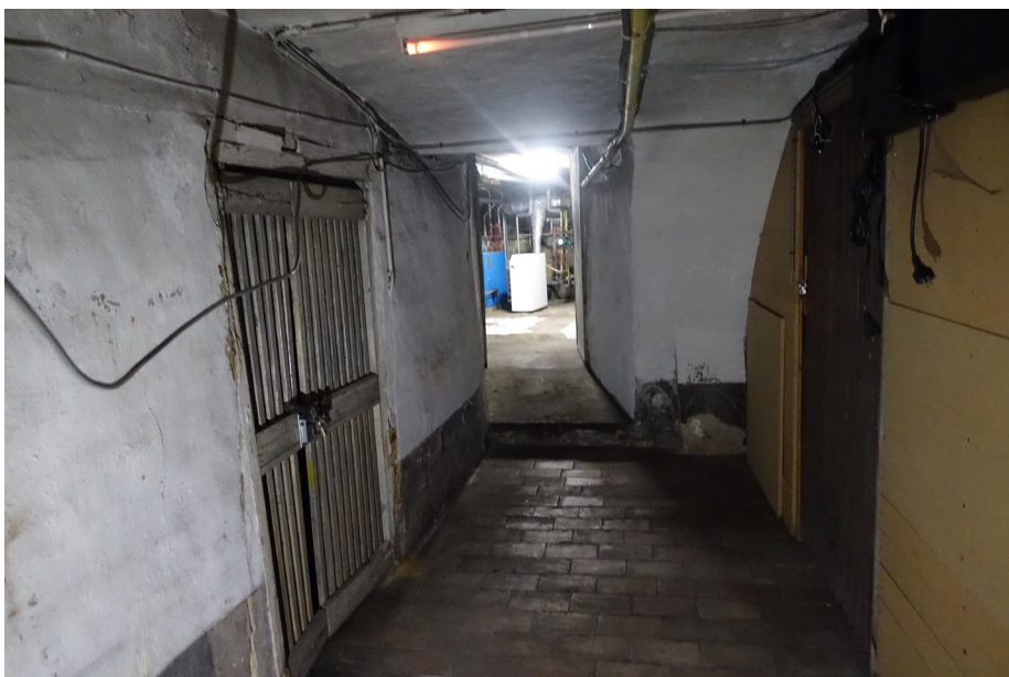
Betonnen plafond in de tweede ruimte.
