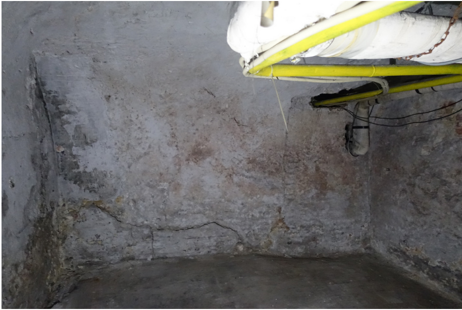
Zicht op de noordelijke wand met rechts dichtgemaakte doorgang.
