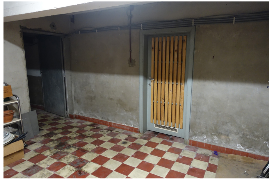
Zicht op de deuropening in de noordelijke wand (links) en de gesloten deur die naar een berging leidt (rechts).
