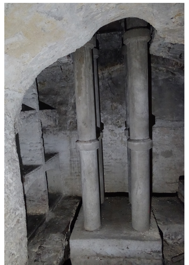
Zicht op de betonnen pijlers met erachter de dichtgemaakte doorgang en links (noordzijde) het wijnrek.
