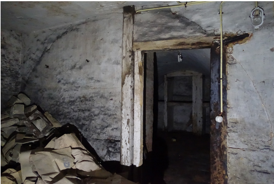
Zicht naar het noorden, wand tussen zuidelijke ruimte en westelijke ruimte met later deels dichtgemaakte wand.
