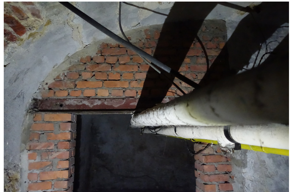
Recent gedichte opening met metalen ligger zodat enkel nog een doorgang naar kelder 4 over blijft.
