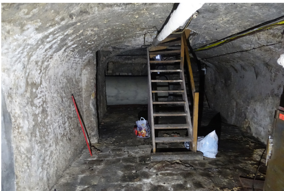
Zicht naar het zuiden met centraal de houten toegangstrap tot de kelder.
