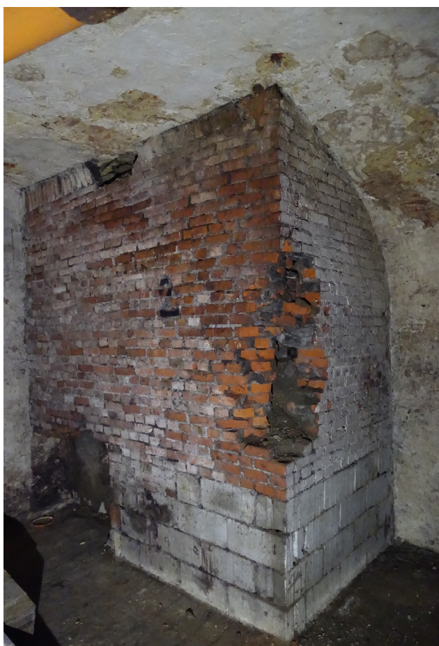
Bakstenen constructie tegen de westelijke wand.
