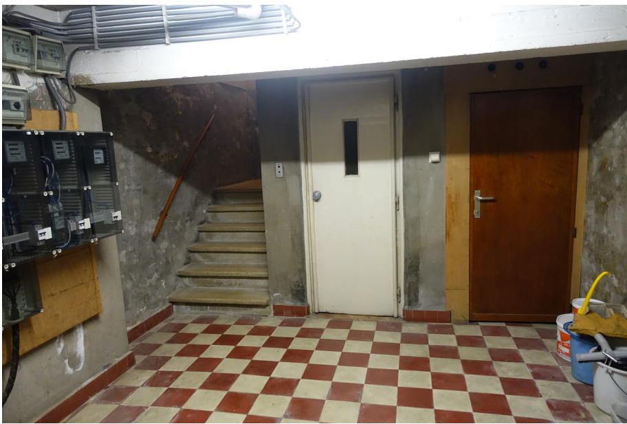
Zicht op de westelijke wand met de trap, lift en berging.
