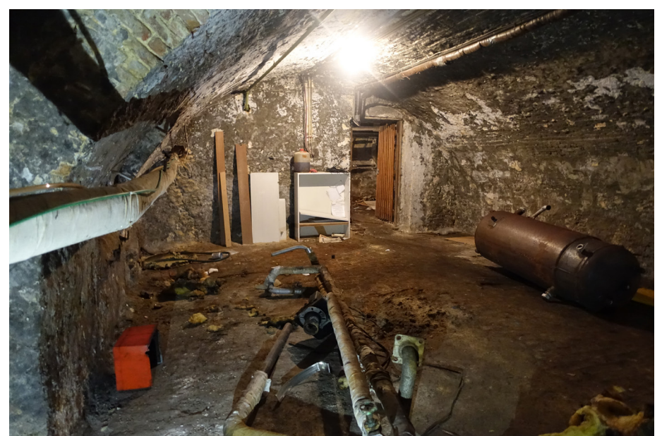
Zicht op de westelijke wand met deuropening naar kelder 3.
