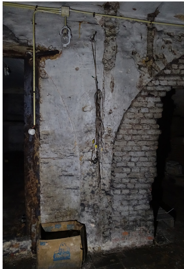
Zicht naar het noorden, scheiding tussen de westelijke en oostelijke kelderruimte waarbij te zien is dat deze wand later deels gedicht werden.
