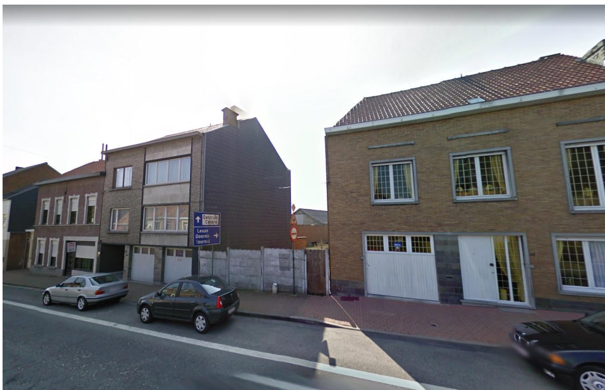
Figuur 7 Zicht op het plangebied vanaf de Kruisstraat. (bron: google maps)
